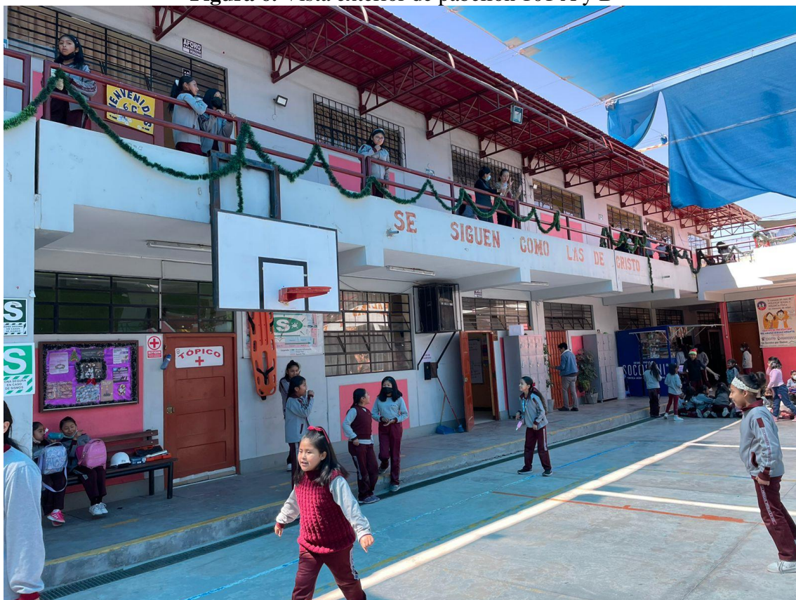
Figura 6. Vista exterior de pabellón 101 A y B
