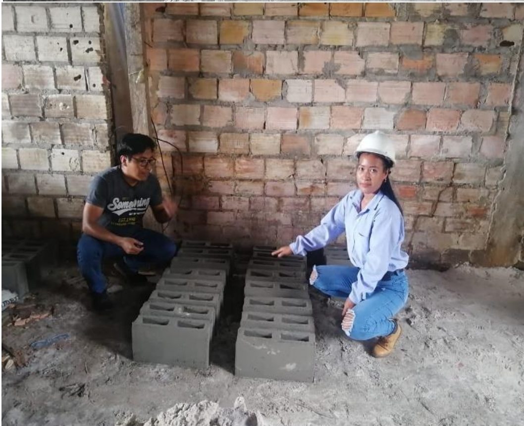
Imagen 3 Acopio de los bloques para su proceso de Fragua.
