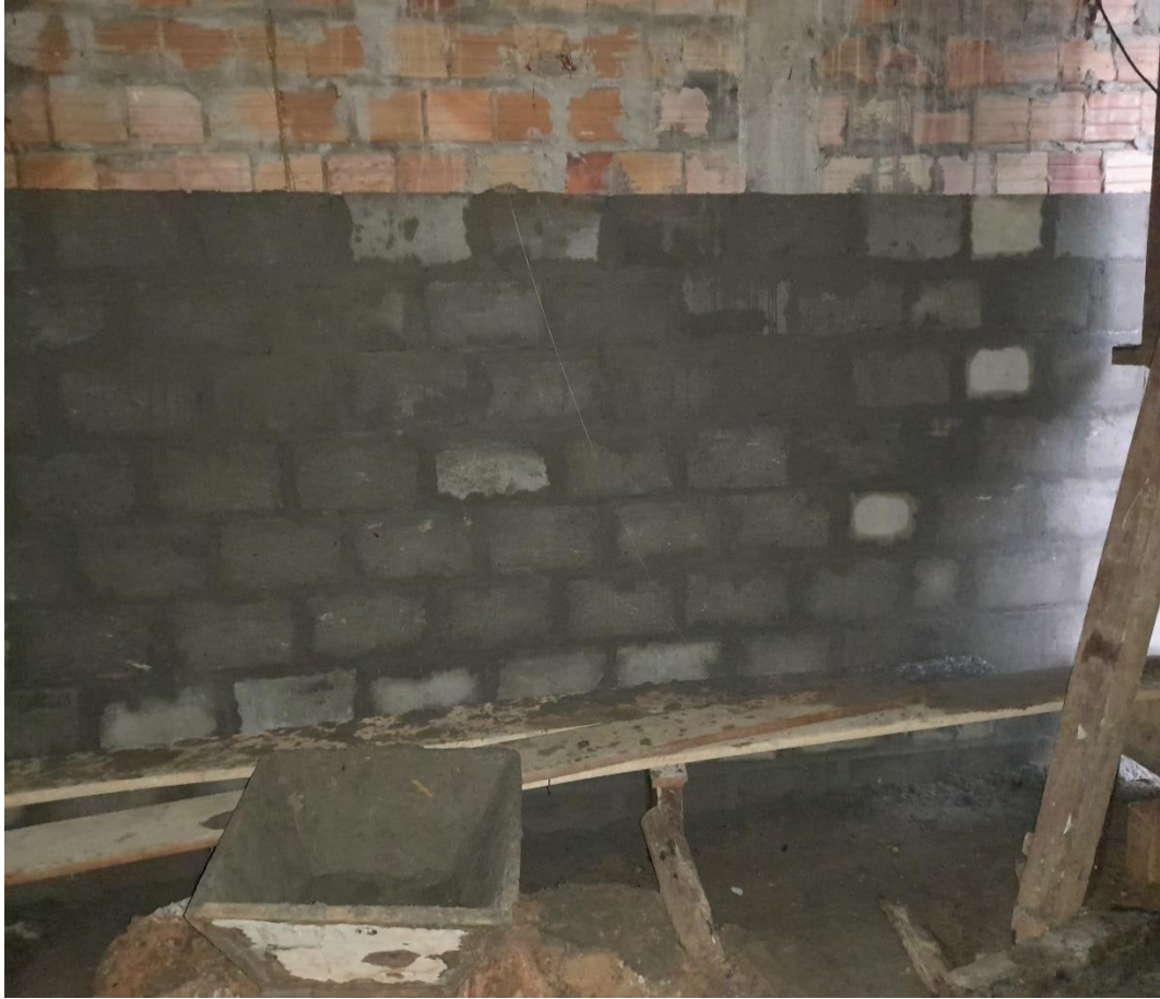
Imagen 5 Asentado de muro con bloques.
