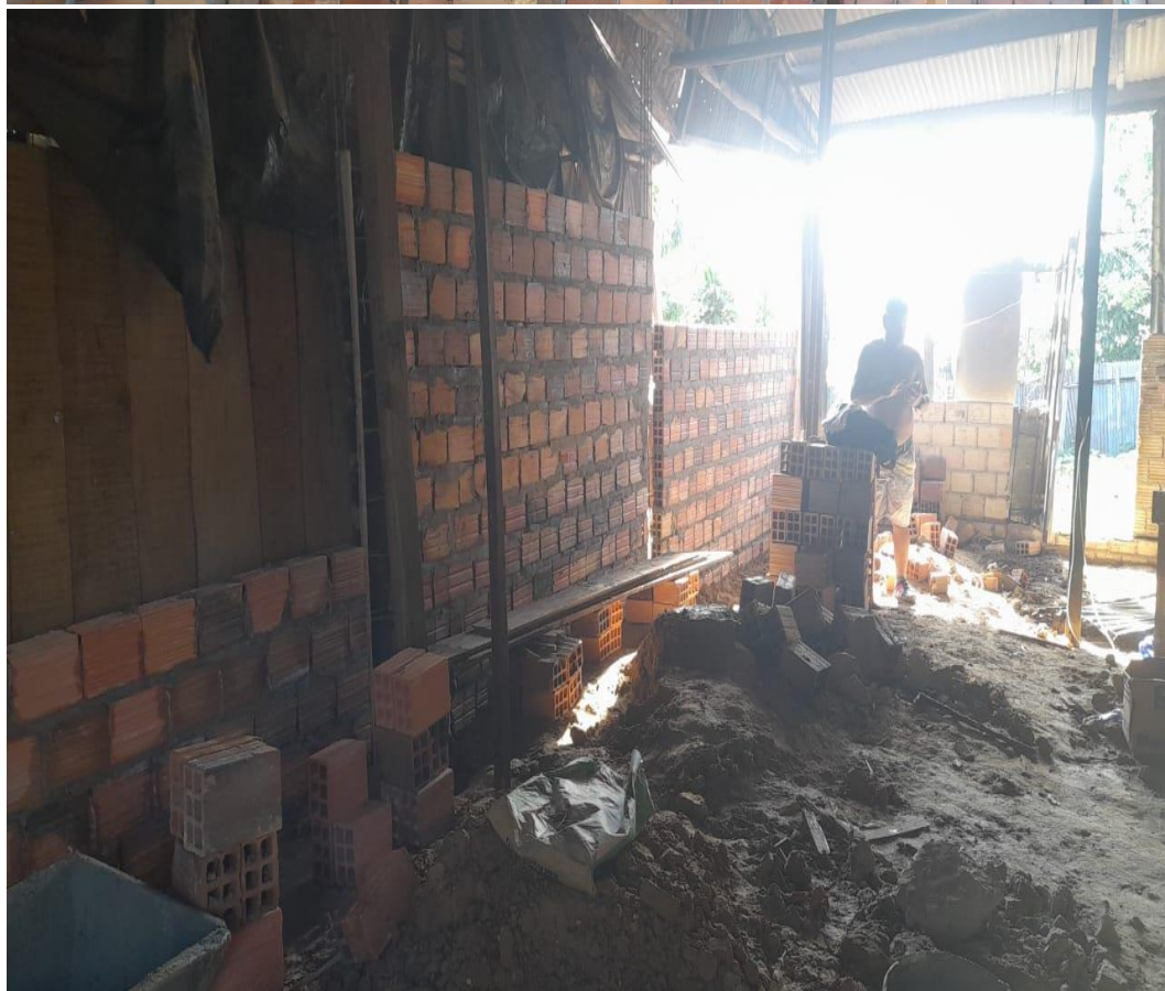
Imagen 7 Asentado de muro con ladrillos de arcilla.
