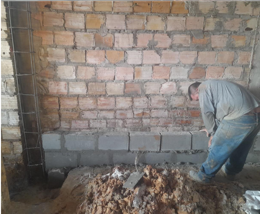
Imagen 4 Asentado de muro con bloques de mortero.
