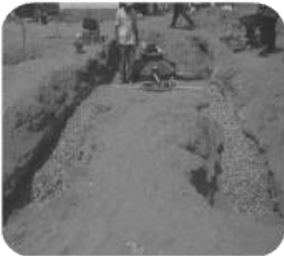
Tipo de zanjas de infiltración horizontal
