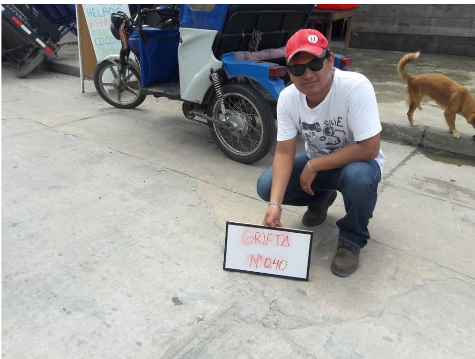
Foto 40 Grieta N° 40 con el tipo de deterioro: Baches
