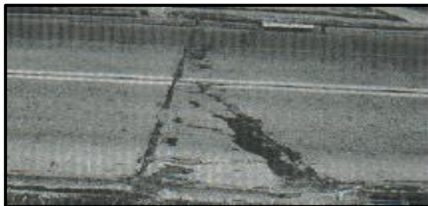
Foto N° 36. Punzonamiento de severidad media.
