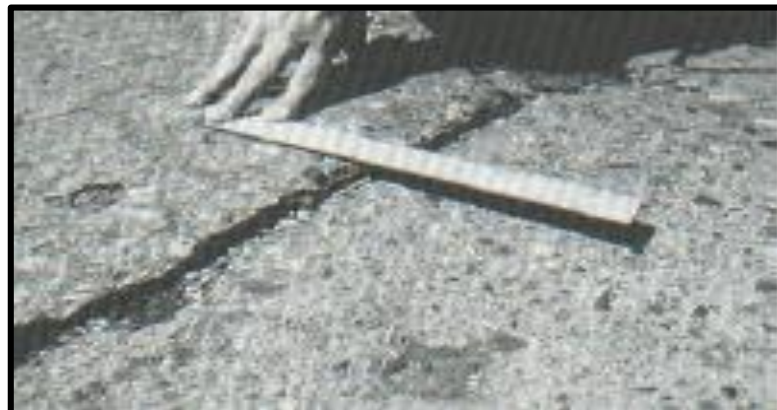
Foto N° 14. Escala de severidad media.
