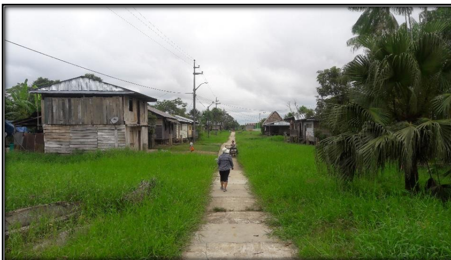
Figura N° 18: Vista de viviendas en estado regular.
