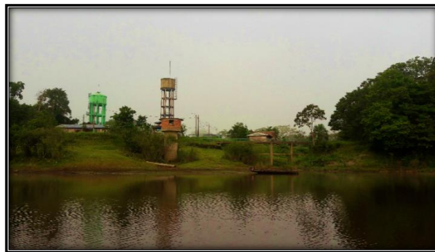
Figura N° 22: Vista de la quebrada Aguas Negras y tanques elevados.
