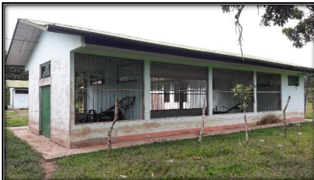
Figura N° 27: Vista infraestructura planta de tratamiento de residuos sólidos. Fuente: Trabajo de Campo.
