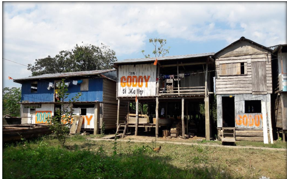
Figura N° 16: Vista de viviendas sobre pilotes.
