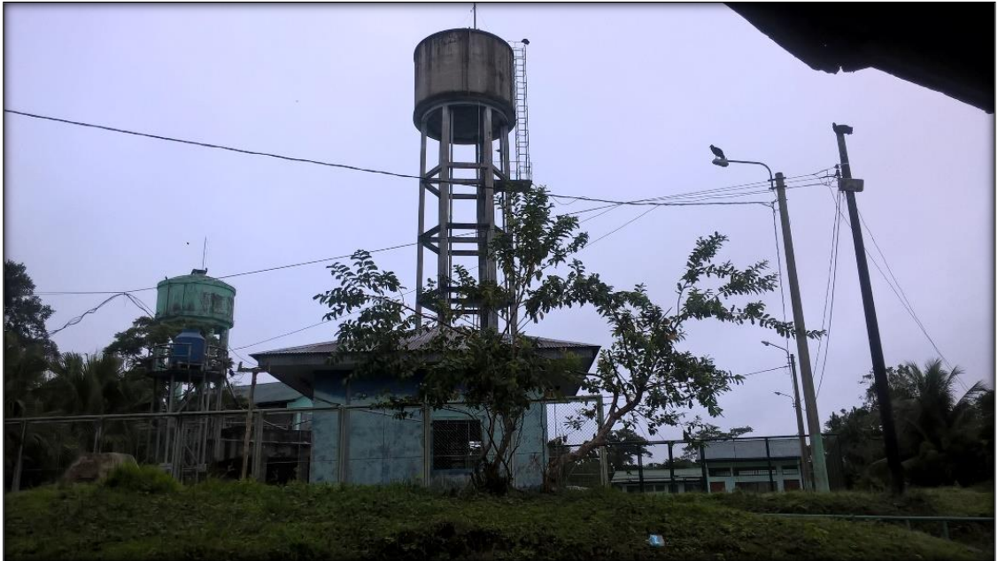
Servicios de Agua Potable del pueblo Francisco de Orellana
