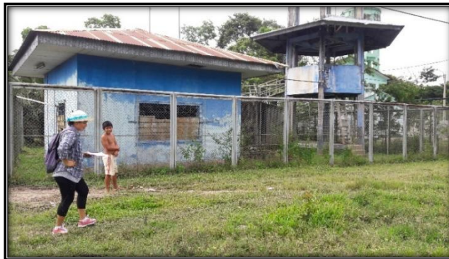
Figura N° 21: Vista de la planta de tratamiento.
