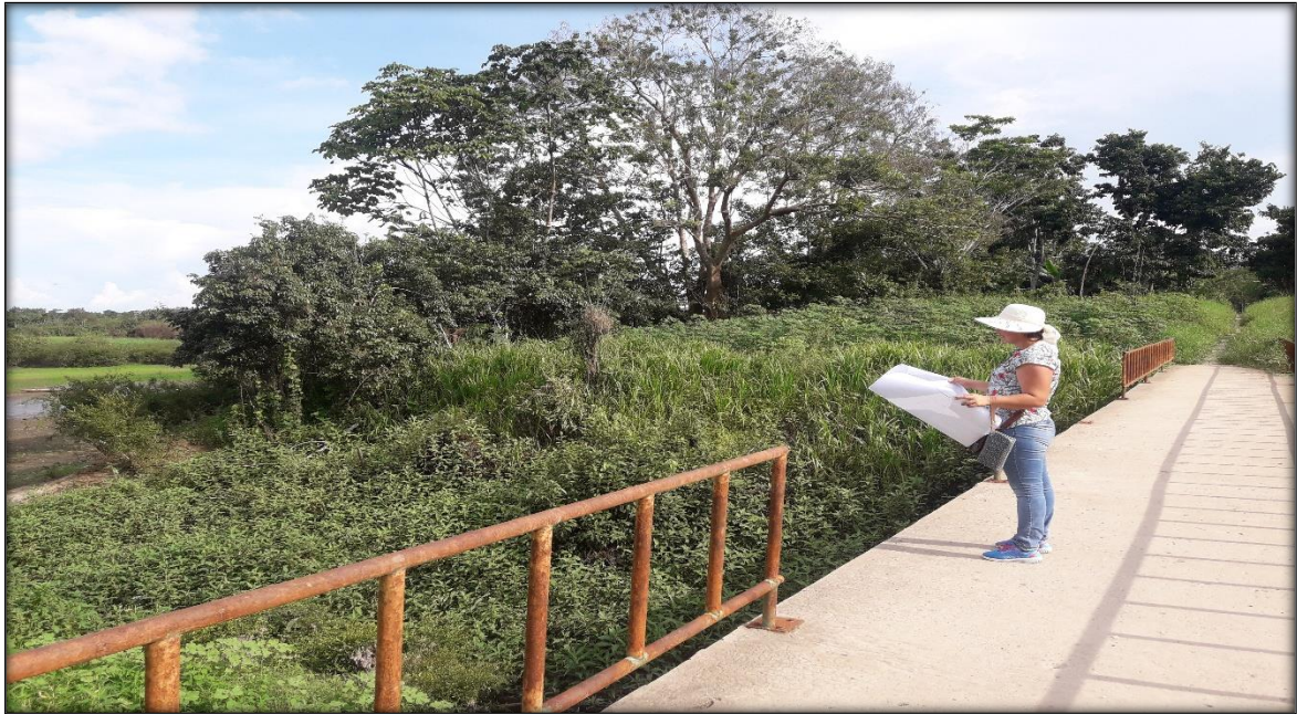
Puentes del pueblo Francisco de Orellana. Fuente: Trabajo Tesistas.
