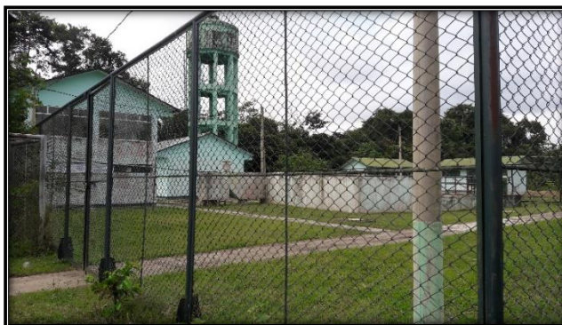
Figura N° 28: Vista infraestructura planta de tratamiento de residuos sólidos y planta de agua potable. Fuente: Trabajo de Campo.
