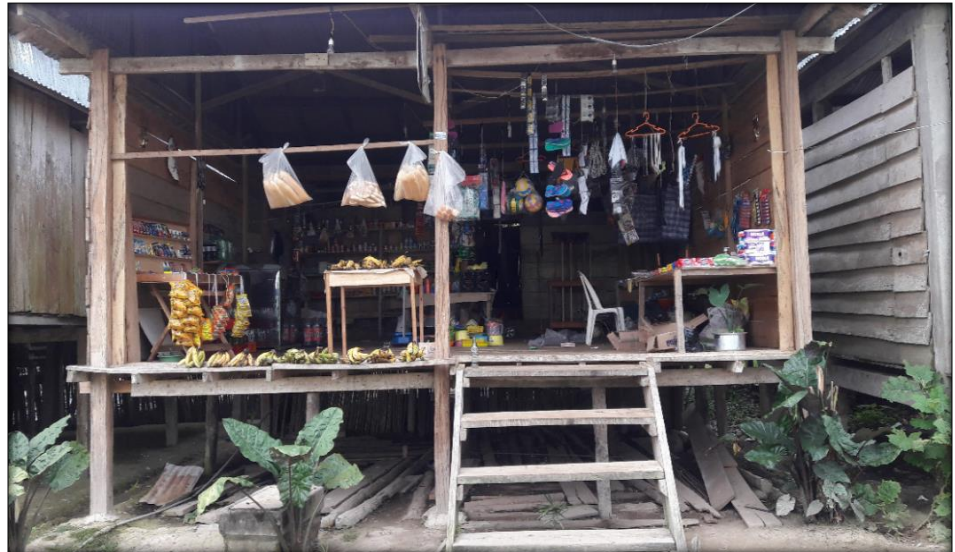
Figura N° 17: Vista de vivienda comercio.
