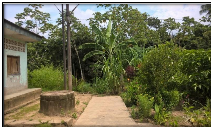
Figura N° 24: Vista de los buzones del sistema de alcantarillado.
