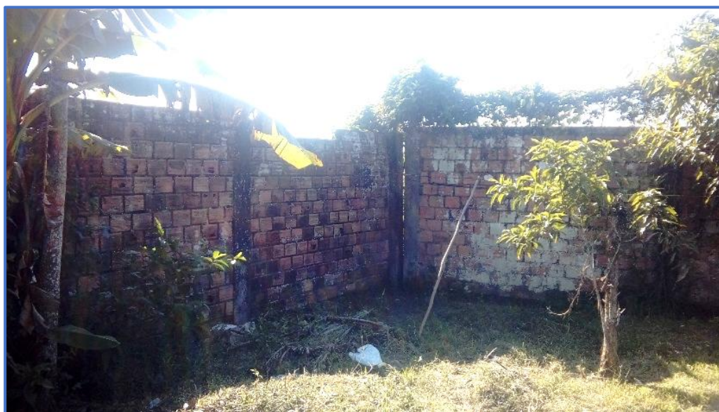
Figura 66: Pared Final de la calle sargento Lores, después se alterna el aeropuerto antiguo Fuente: Foto Tomada por autor
