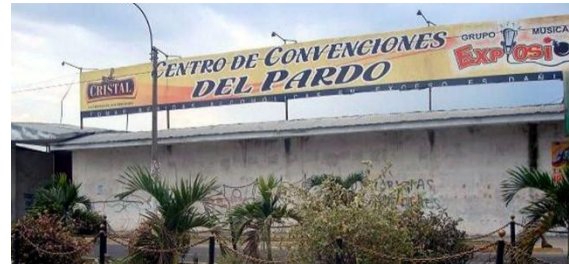
Figura 2. Local de Centro de Convenciones del Pardo.
