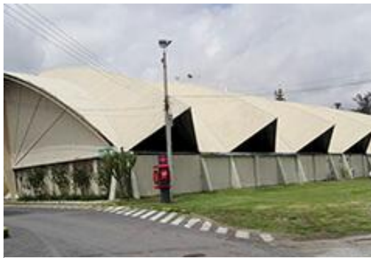
Figura 12. Vista exterior de Centro de Convenciones Cerro Juli
