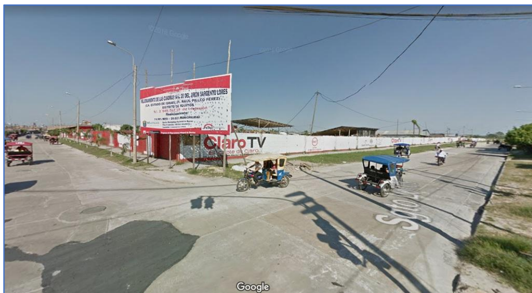
Figura 69: Vista de cruce de calle Alzamora con av. Srto. Lores con el muro perimétrico del aeropuerto antiguo Fuente: Google maps.
