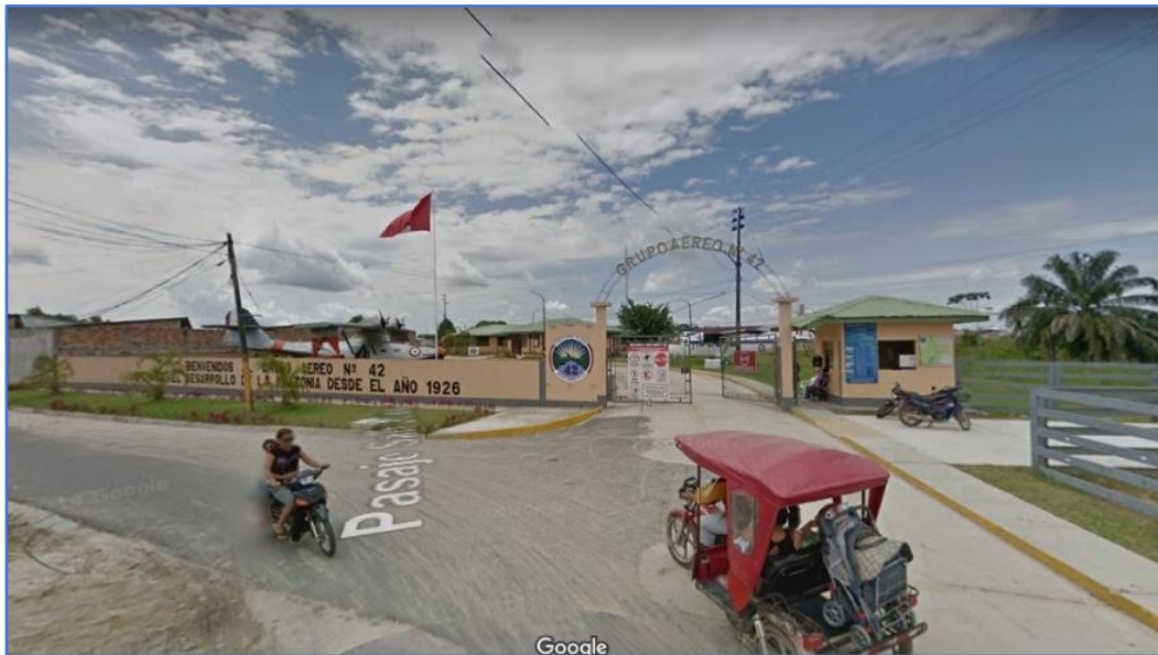
Figura 68: Acceso principal de la base aérea grupo 42 – en el aeropuerto antiguo de Iquitos Fuente: Google maps.
