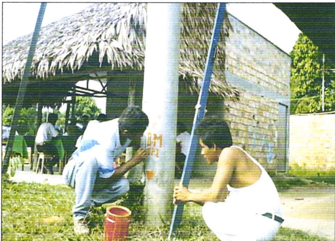
Colocación de BM.
