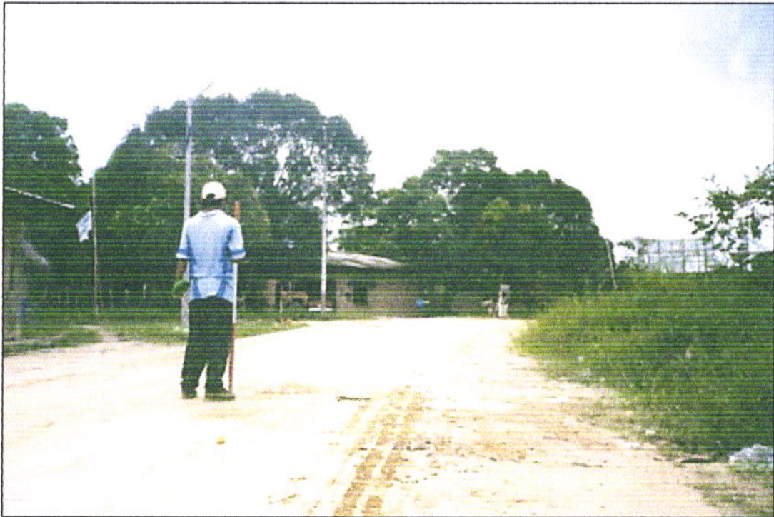
Nivelación del eje de la vía.
