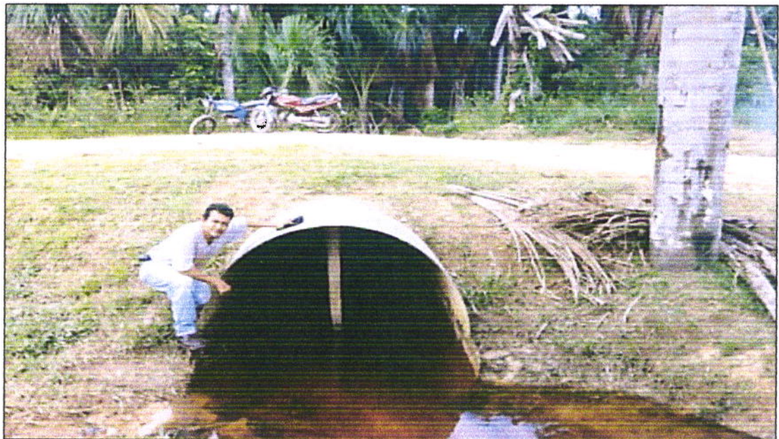
Alcantarilla de la progresiva 5+385, se proyecta construir sus cabezales.
