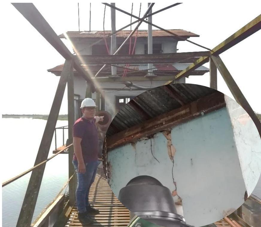
*Vista de ingreso a la **caseta del Caisson N°01** y observamos fisuras en los muros, asimismo en las coberturas muestran deterioro. Fuente: Elaboración propia (2019).*
