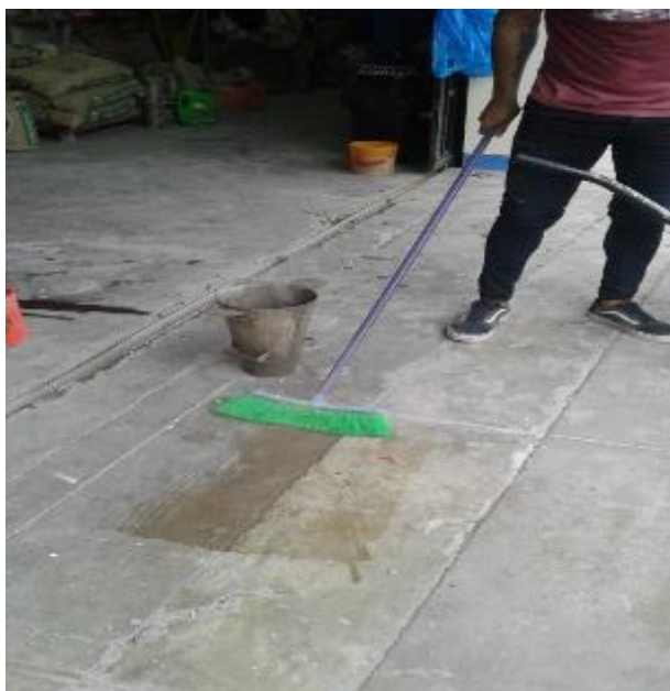
FOTO N° 49: limpieza del piso, para evitar polvo.
