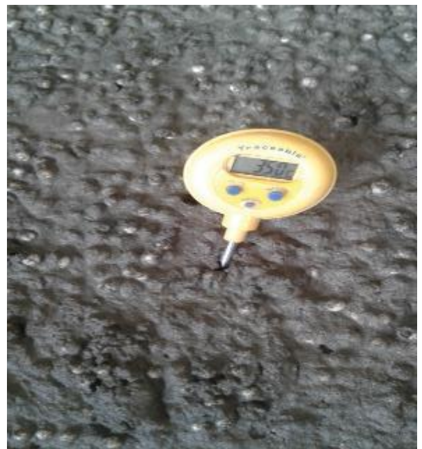
FOTO N° 58: Se dejó el dispositivo en el concreto durante al menos 2 minutos.
