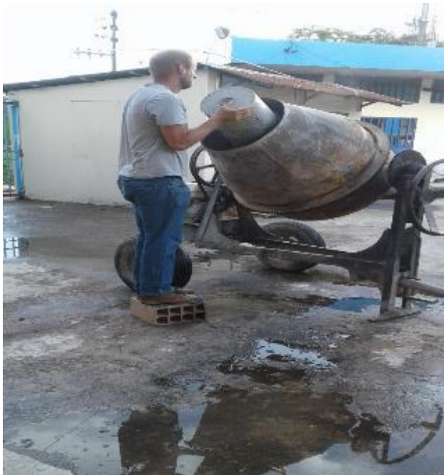
FOTO N° 41: Vaciado de los materiales al trompo.
