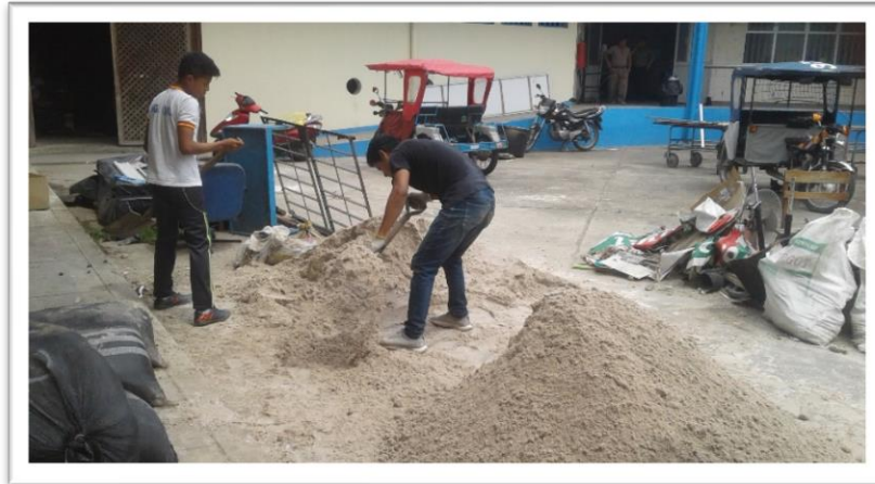
FOTO N° 2 Mezclado del agregado fino por 3 veces
