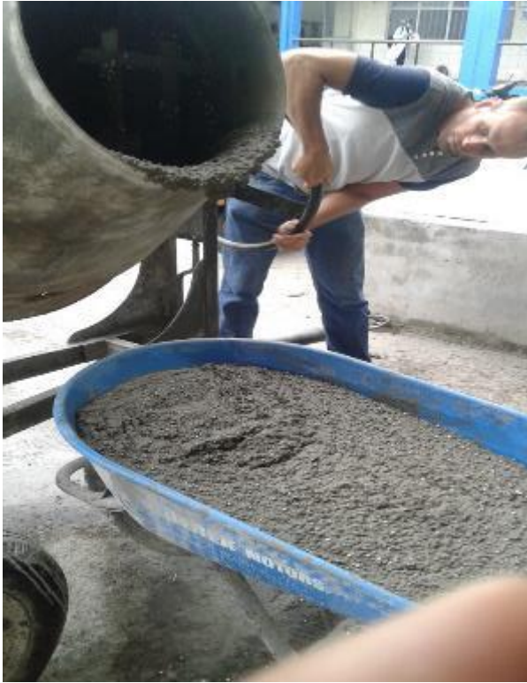
FOTO N° 43: Vaciado de la mezcla en carretilla para el transporte.
