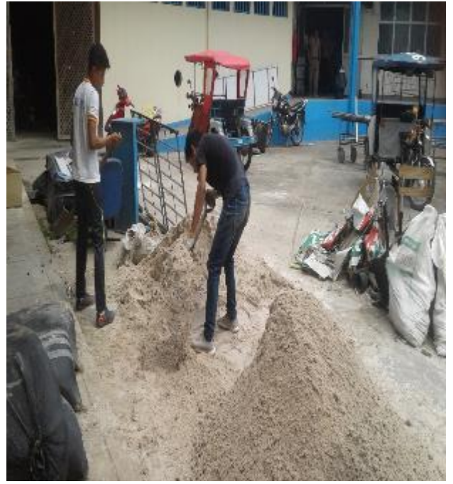
FOTO N° 10: Mezclado del agregado fino en tres capas.
