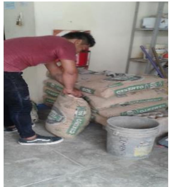
FOTO N° 08: Almacenamiento del cemento Sol.
