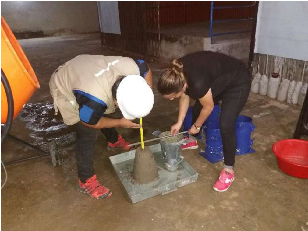
Figura N° 31: verificación del asentamiento con el cono de Abrams.
