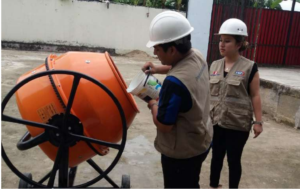
Figura N° 30: Elaboración del concreto
