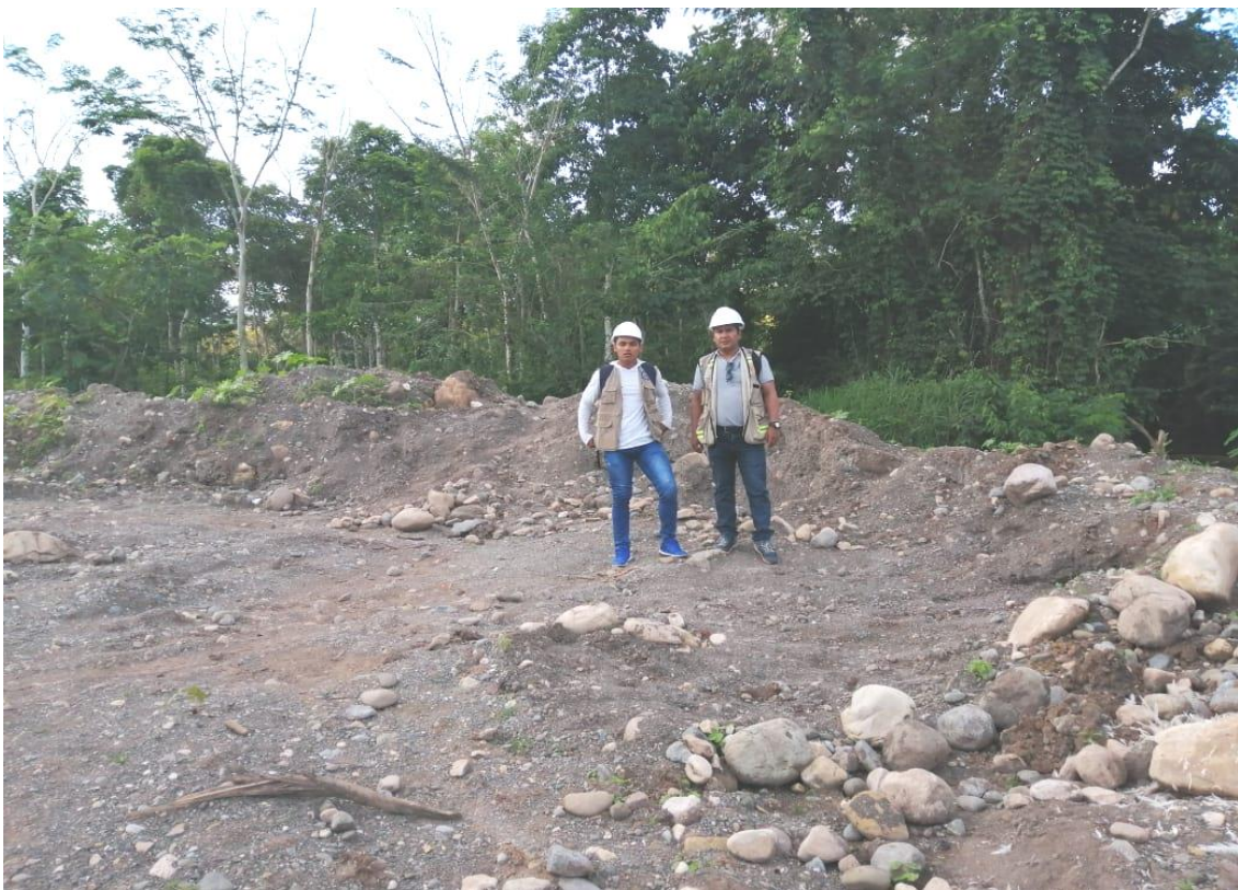
FOTO N°12: LAS DOS CANTERA CUENTAN CON MATERIAL APROPIADO Y BUENO PARA LA EJECUCION DEL TRABAJO.
