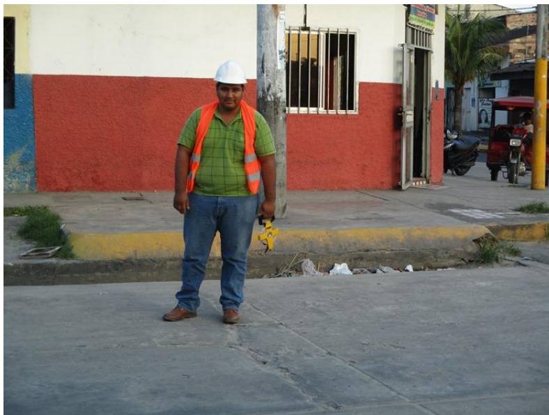
Figura N° 02: Se observa grieta lineal de severidad alta.
