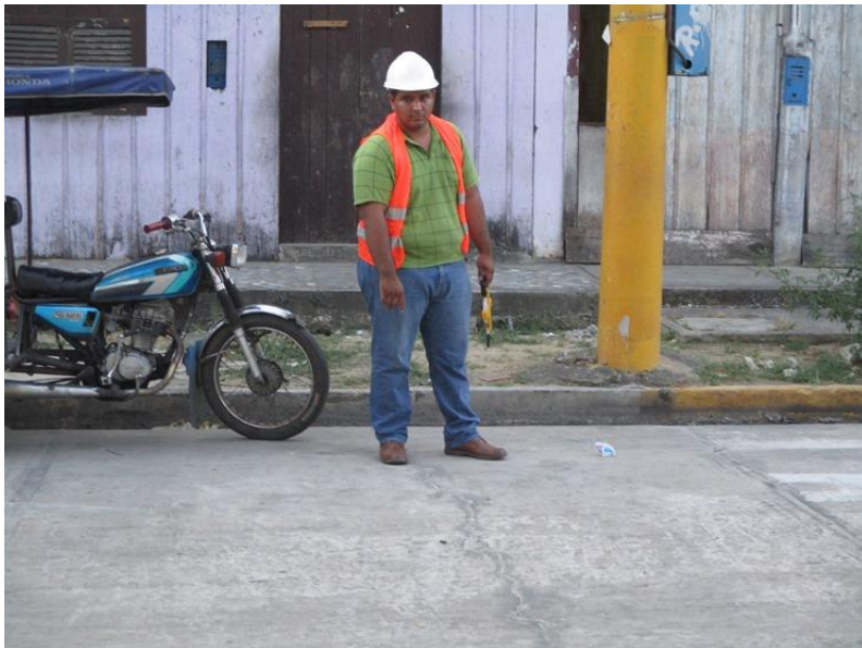
Figura N° 06: Se observa grieta lineal de severidad alta.
