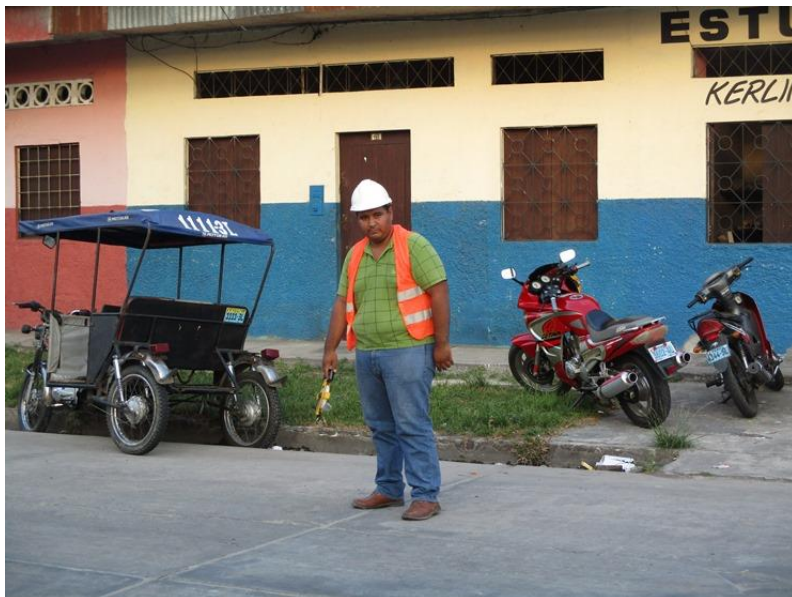
Figura N° 10: Se observa grieta lineal de severidad media.
