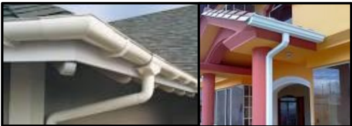
Figura 01 : canaletas de recolección
