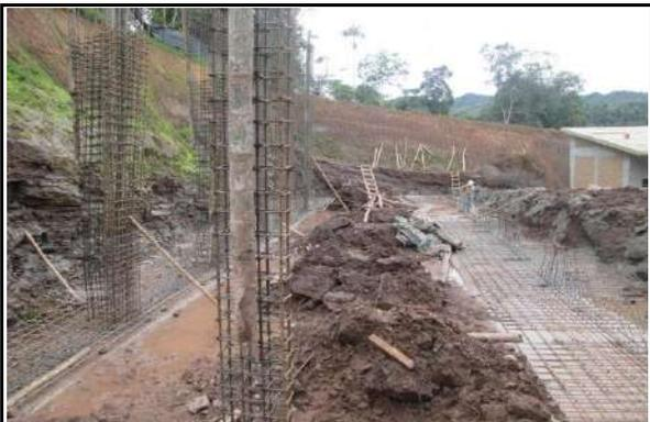
**Fotografía N° 15.**-Levantamiento de información en partidas de acero, encofrado y concreto en zapatas y vigas de cimentación. Semana 2 (21-11-19).
