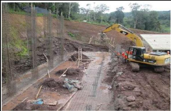
**Fotografía N° 13.**-Levantamiento de información en partidas de acero, encofrado y concreto en zapatas y vigas de cimentación. Semana 2 (21-11-19).
