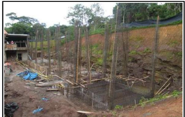
**Fotografía N° 16.**-Levantamiento de información en partidas de acero, encofrado, concreto zapatas y vigas de cimentación y columnas. Semana 3 (29-11-19).
