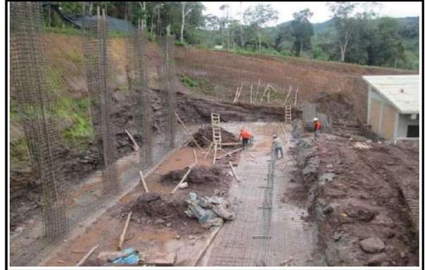
**Fotografía N° 14.**-Levantamiento de información en partidas de acero, encofrado y concreto en zapatas y vigas de cimentación. Semana 2 (21-11-19).
