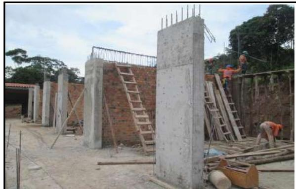
**Fotografía N° 22.**-Levantamiento de información en partidas de acero, encofrado, concreto en columnas y vigas 2do Nivel. Semana 5 (13-12-19).
