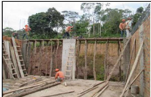
**Fotografía N° 24.**-Levantamiento de información en partidas de acero, encofrado, concreto en columnas y vigas 2do Nivel. Semana 5 (13-12-19).
