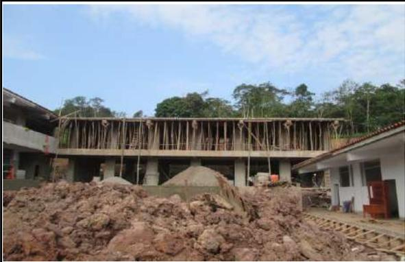
**Fotografía N° 25.**-Levantamiento de información en partidas de acero, encofrado, concreto en columnas, vigas y losas 2do Nivel. Semana 6 (20-12-19).
