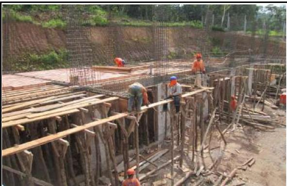
**Fotografía N° 21.**-Levantamiento de información en partidas de acero, encofrado, concreto en columnas, vigas y Losas 1er nivel. Semana 4 (07-12-19).
