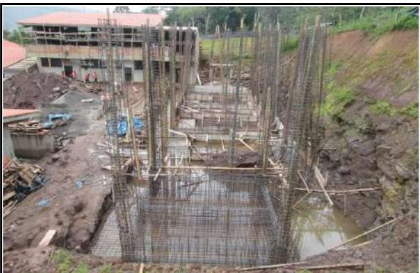
**Fotografía N° 17.**-Levantamiento de información en partidas de acero, encofrado, concreto zapatas y vigas de cimentación y columnas. Semana 3 (29-11-19).
