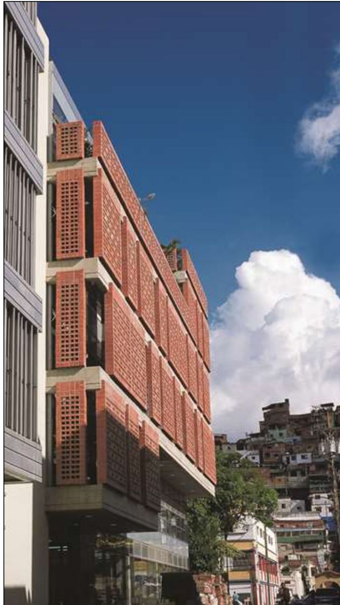
Figura 28: Tratamiento de fachada, sede de Alcaldía de Baruta
