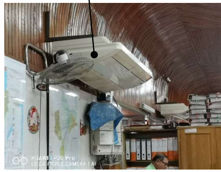
Figura 21: Ubicación de Equipo de Aire Acondicionado Tipo Split de 40,000 BTU
