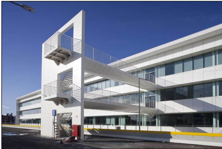
Figura 32: Escalera Salida de Emergencia / Municipalidad de Seixal - Portugal
