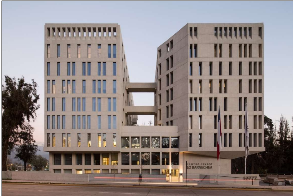
Figura 37: Fachada Principal /Municipalidad Lo Barnechea – Santiago de Chile
