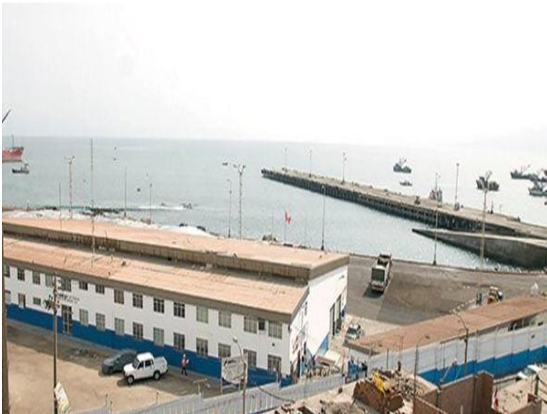
Figura 8: Vista panorámica de las instalaciones del T.P. Ilo
