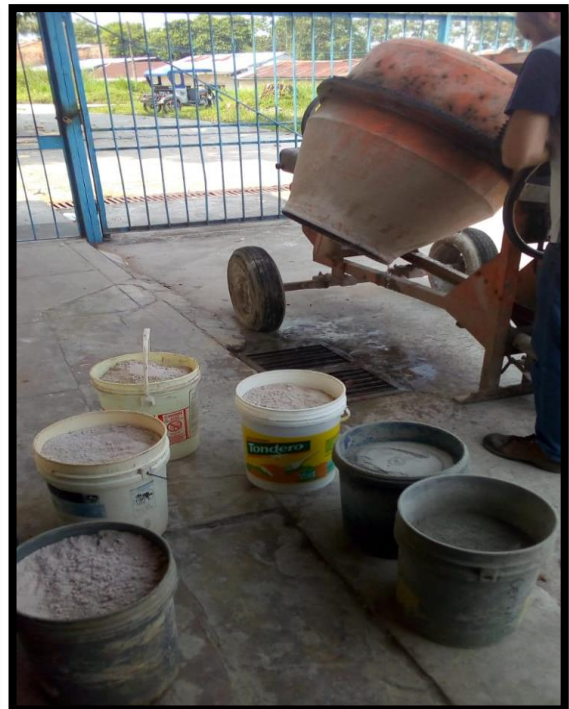
Preparación del concreto
