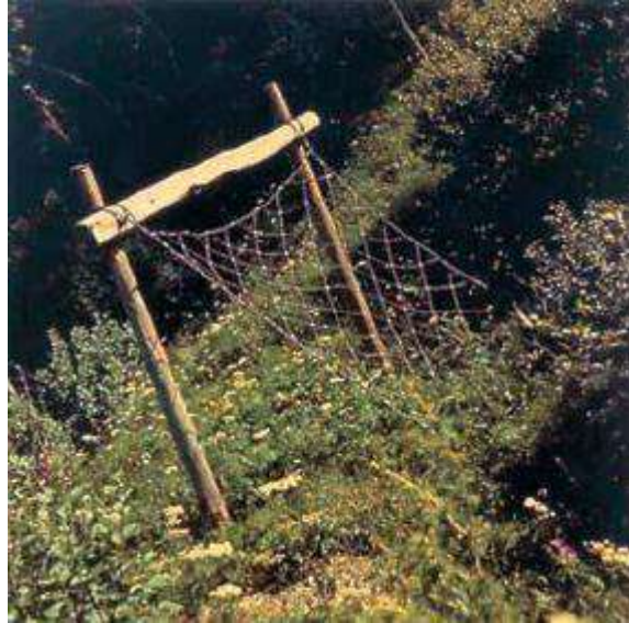
Figura 03. Primeras barreras individuales con marco a base de madera.
