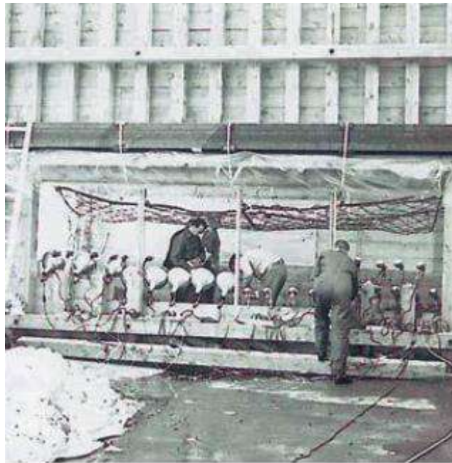
Figura 05. Primeras pruebas en barreras con redes de cable de acero.
