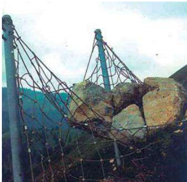
Figura 04. Barrera colocada para la protección contra hielo.
