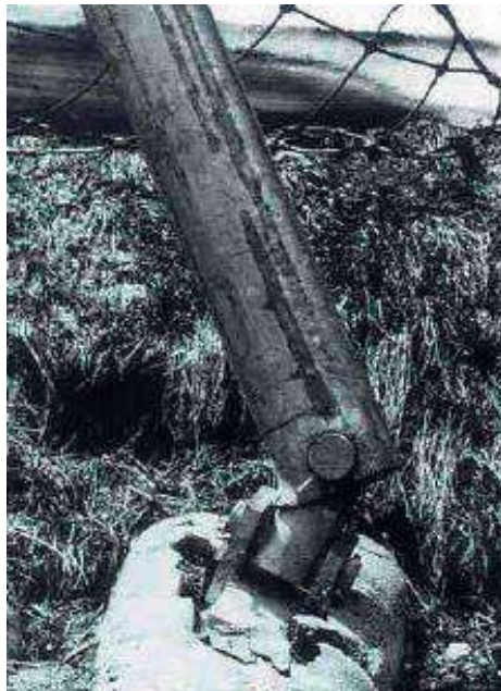
Figura 13. Apoyo articulado en la base de los postes.
