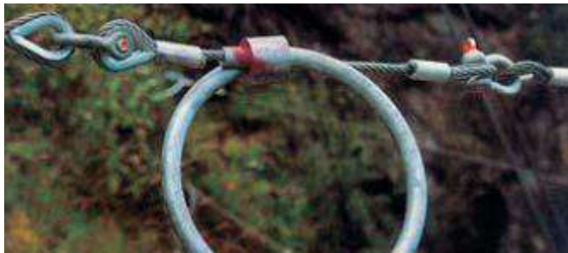
Figura 09. Sistema de frenado a base de anillos.
