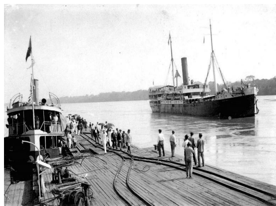
Imagen N° - Vista desde la parte superior del Muelle Booth Line
