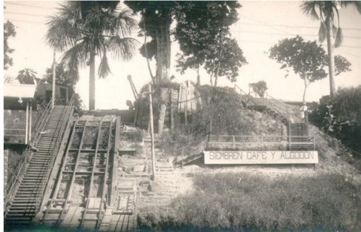
Fotografía N° 21 - Tercera faceta del muelle Booht Line, se subían
