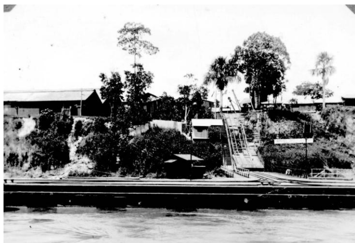
Fotografía N° 20 - Tercera faceta del muelle, estructura de madera.
