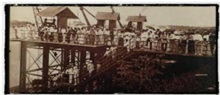
Imagen N° - Vista lateral de la plataforma superior de área de grúas.
