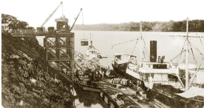
Fotografía N° 12 - Muelle Booth Line desde una vista lateral.
