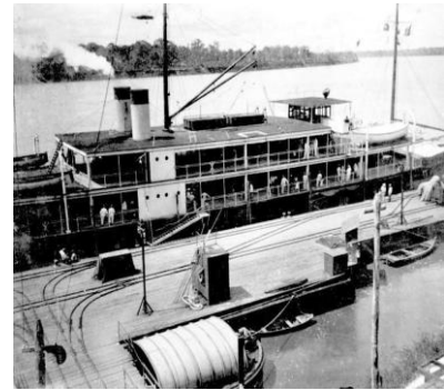
Imagen N° - Vista desde la parte superior del Muelle Booth Line
