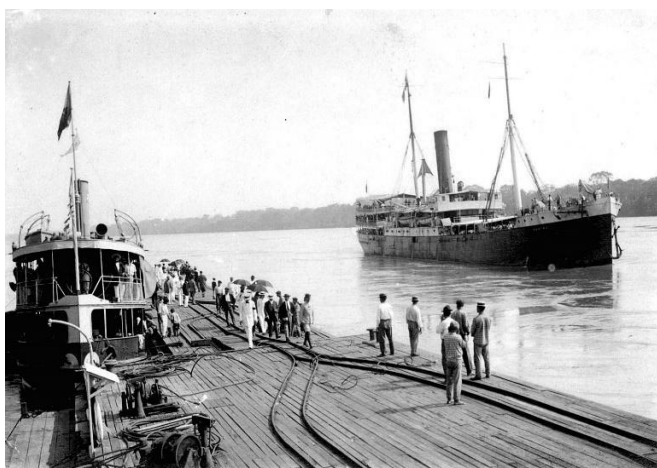
Fotografía N° 10 - Plataforma de acero con madera, rieles para los vagones tipo góndola que transportaban la mercadería hacia las embarcaciones y viceversa.
