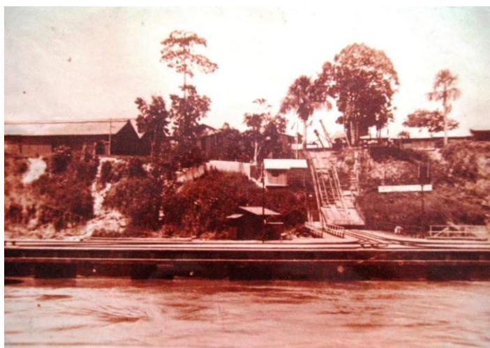
Fotografía N° 17 -Tercera faceta del muelle Bocht Line, después que el río amazona se lo llevó.
