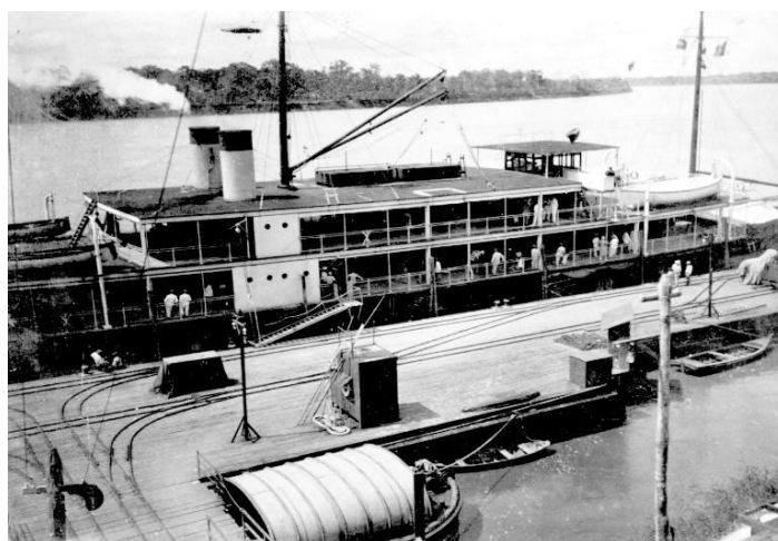
Fotografía N° 11 - Vista desde la parte superior del muelle Booth Line.
