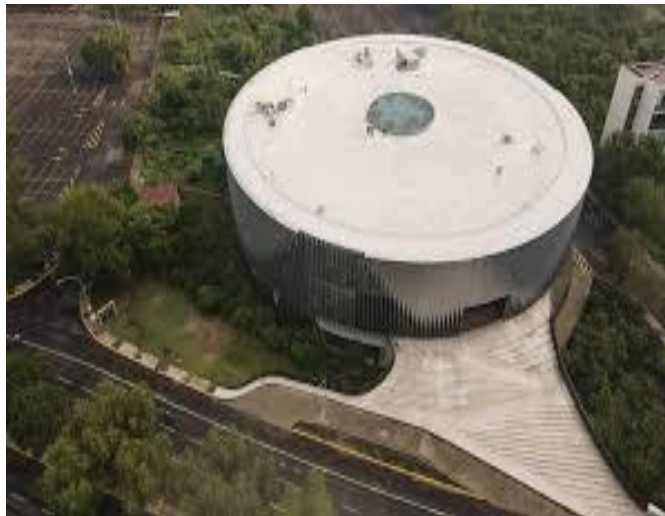
Figura N° 4: Pabellón Nacional de la Biodiversidad
