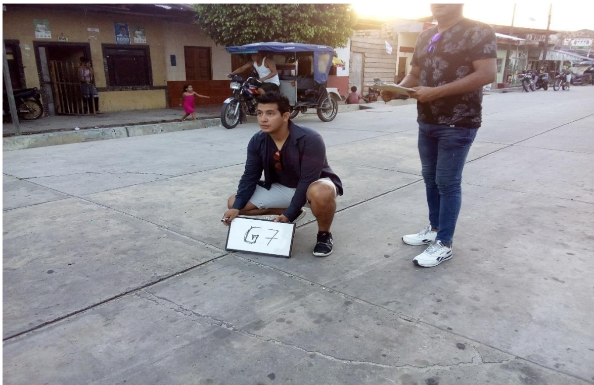
Foto 7 Grieta N° 7 con deterioro: Grietas longitudinales y transversales, está ubicada en la progresiva 0 + 159m.
