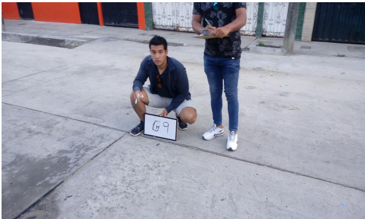
Foto 9 Fisura N° 9 con deterioro: Deficiencias del sellado, está ubicada en la progresiva 0 + 206,32m.
