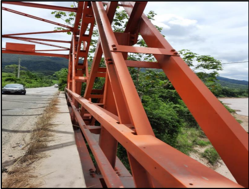
Foto N°21: Se aprecia el estado actual de la sección metálica - Lado derecho
