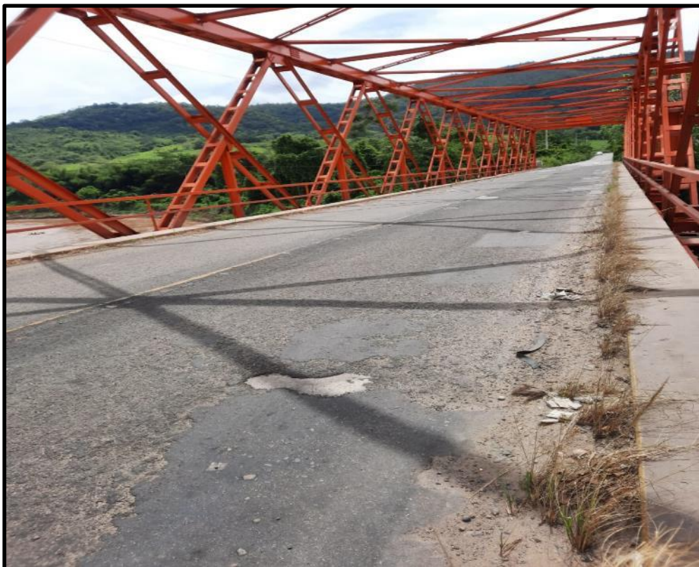
Foto N°15: Se aprecia el estado actual de la vía - Carpeta de rodadura.
