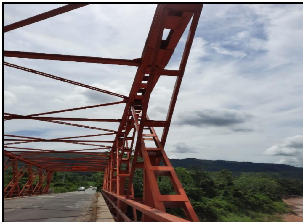
Foto N°18: Se aprecia el estado actual de la sección metálica - Lado derecho
