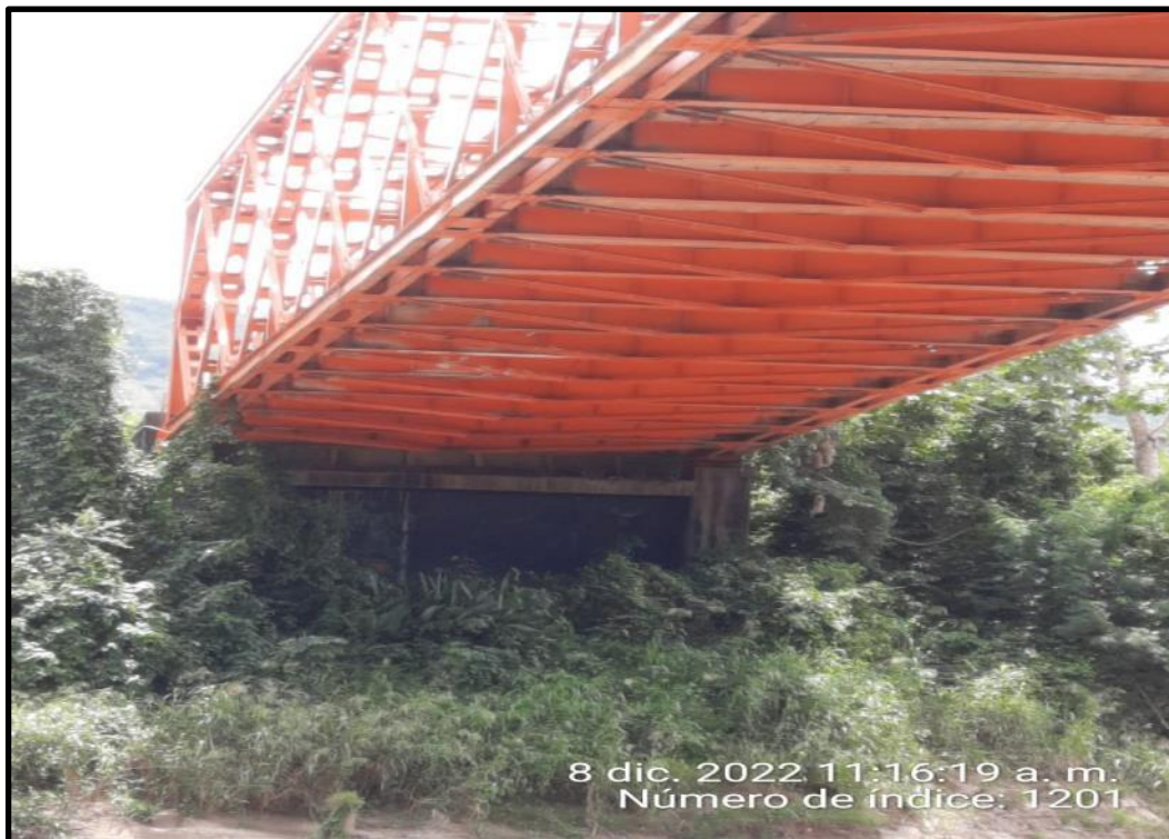
Foto N°39: Se aprecia los pilares del puente final a picota.
