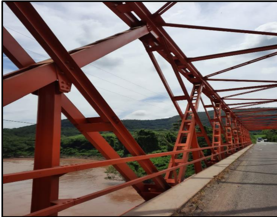
Foto N°09: Se aprecia las secciones metálicas del puente - Lado izquierdo
