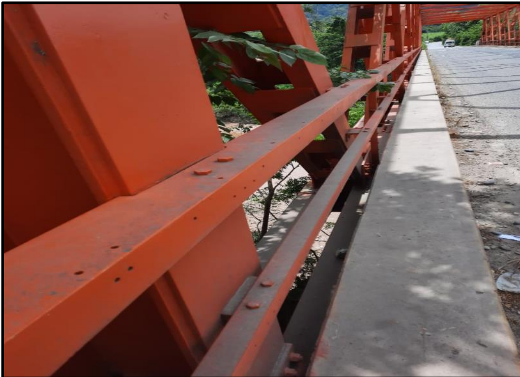
Foto N°06: Se aprecia el estado actual de la vereda - Lado izquierdo
