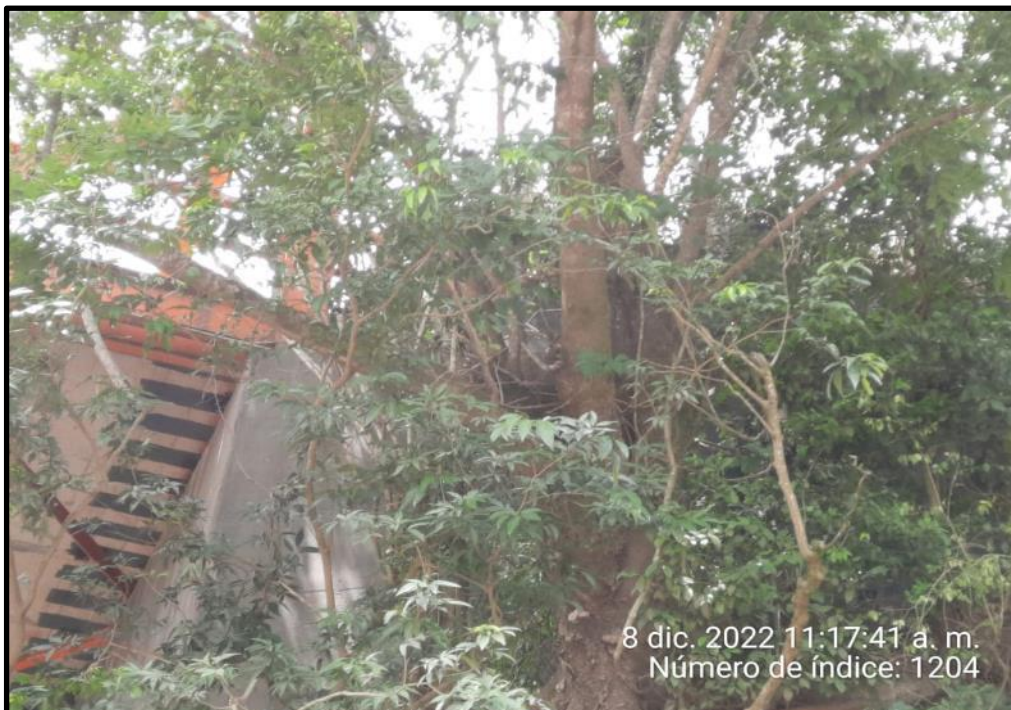
Foto N°35: Se aprecia el contrafuerte sentido Tarapoto - Picota.
