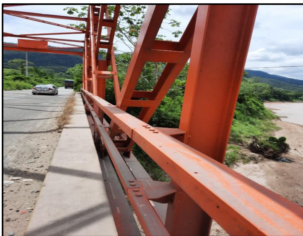
Foto N°20: Se aprecia el estado actual de la sección metálica - Lado derecho
