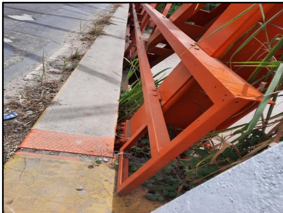
Foto N°10: Se aprecia las secciones metálicas y la vereda - Lado derecho
