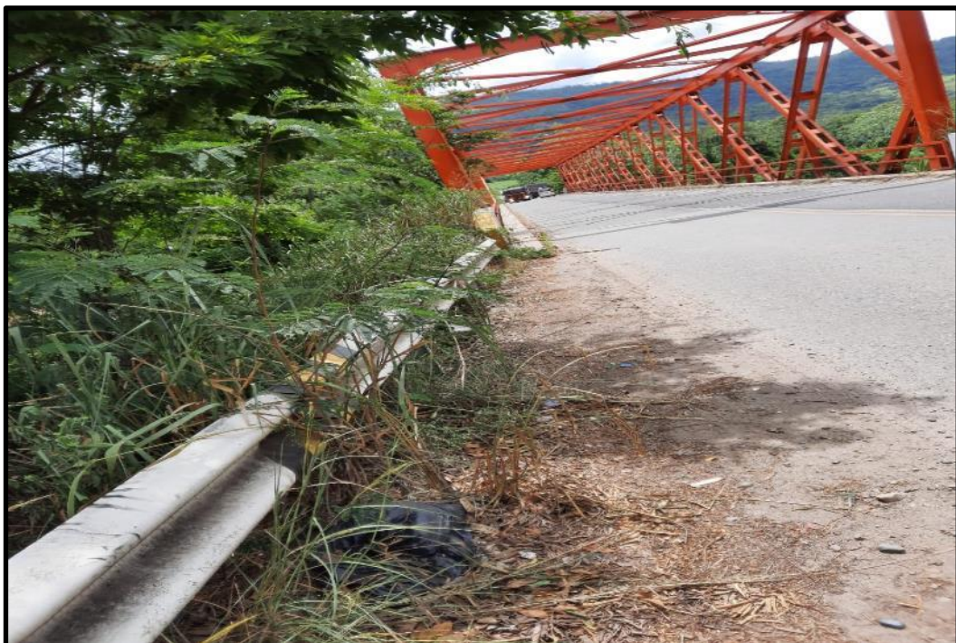
Foto N°42: Se aprecia las Guardavías metálicas.
