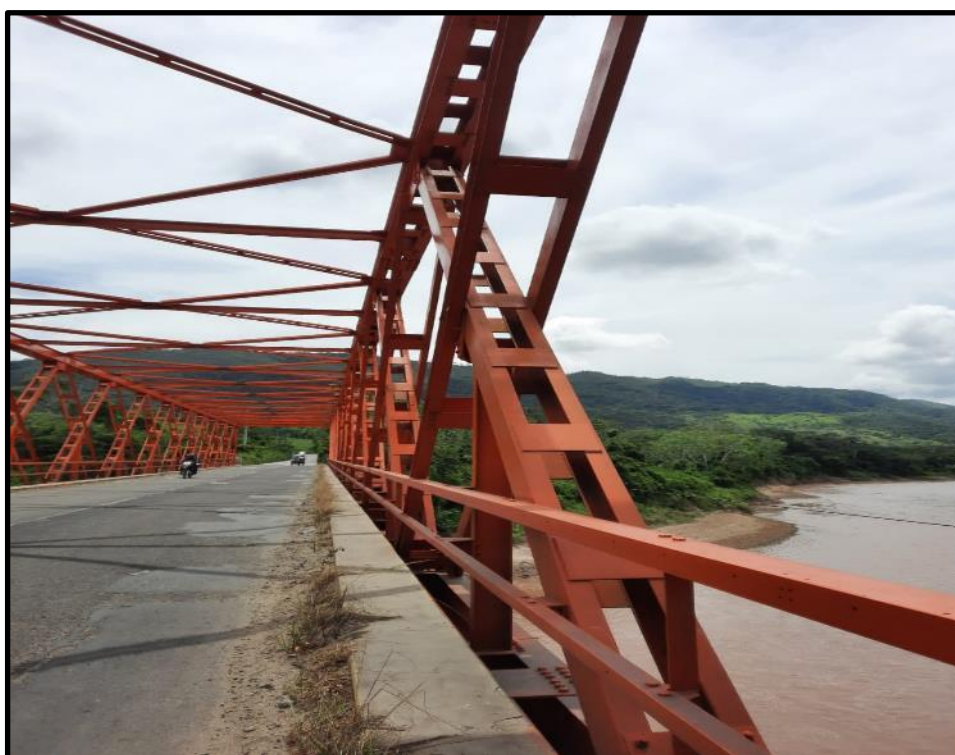
Foto N°12: Se aprecia las secciones metálicas y el estado de la vía - Lado derecho
