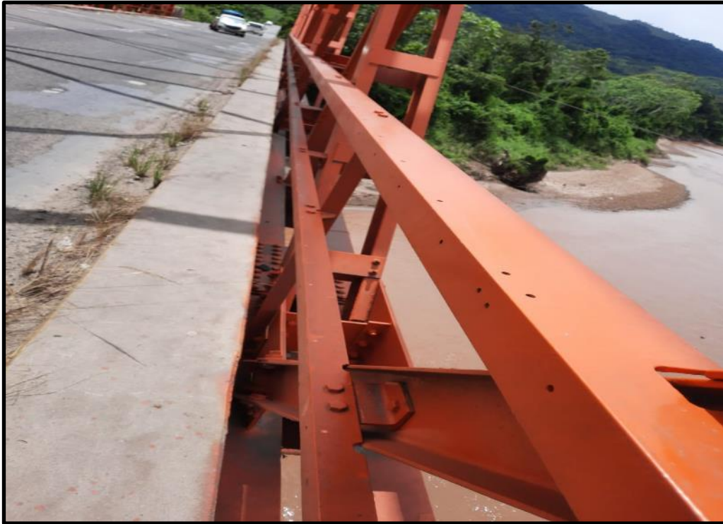
Foto N°17: Se aprecia el estado actual de la sección metálica y vereda - Lado derecho
