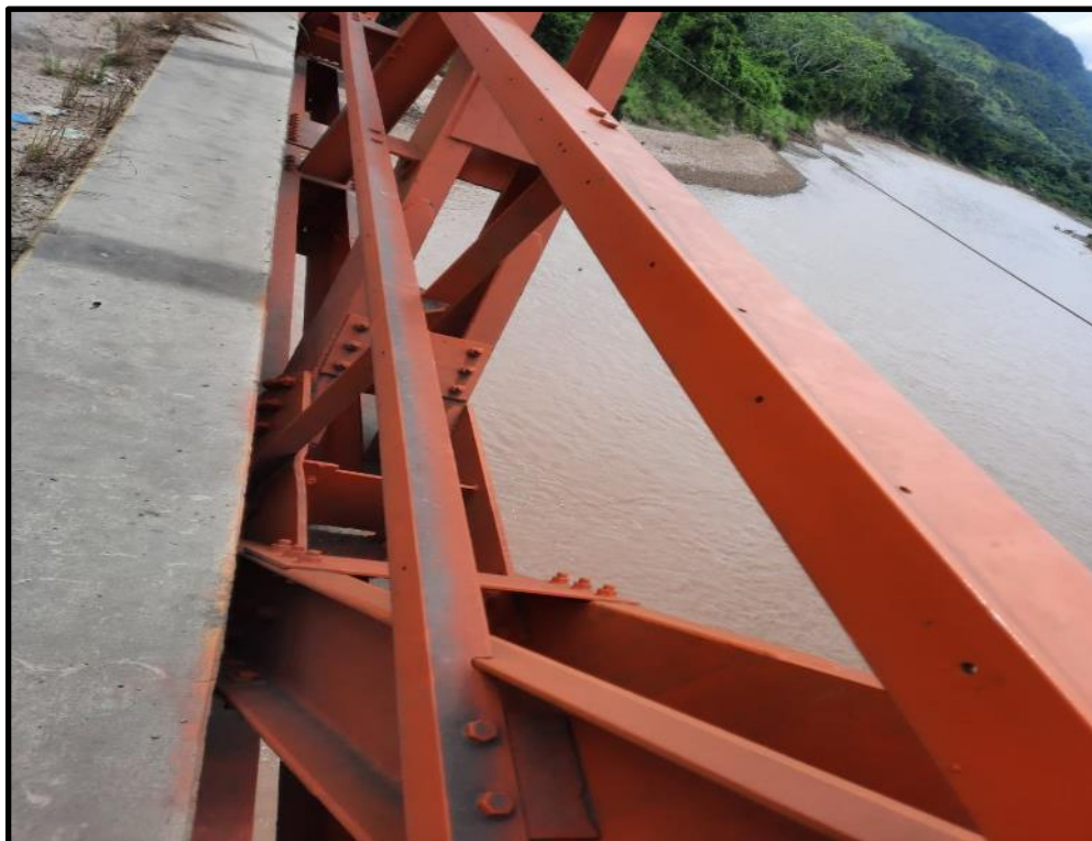
Foto N°13: Se observa las secciones metálicas y vereda - Lado derecho
