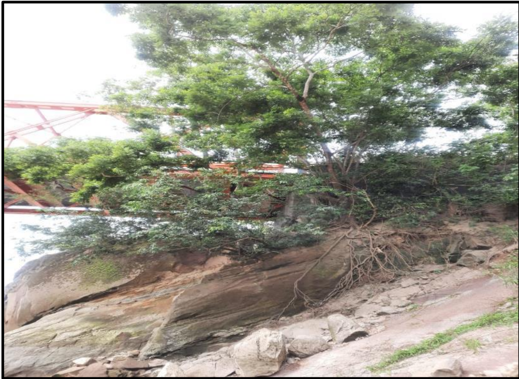
Foto N°41: Se aprecia el estado de márgenes de río.
