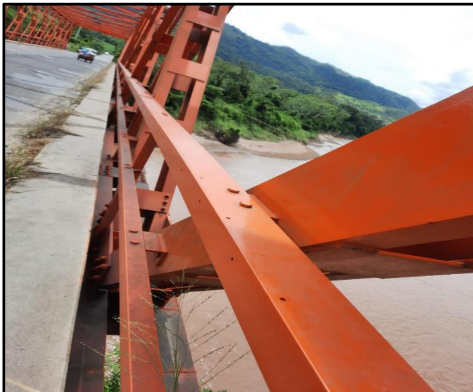
Foto N°11: Se aprecia las secciones metálicas - Lado derecho
