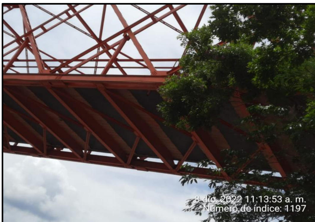
Foto N°40: Se observa las secciones transversales y longitudinales metálicas
