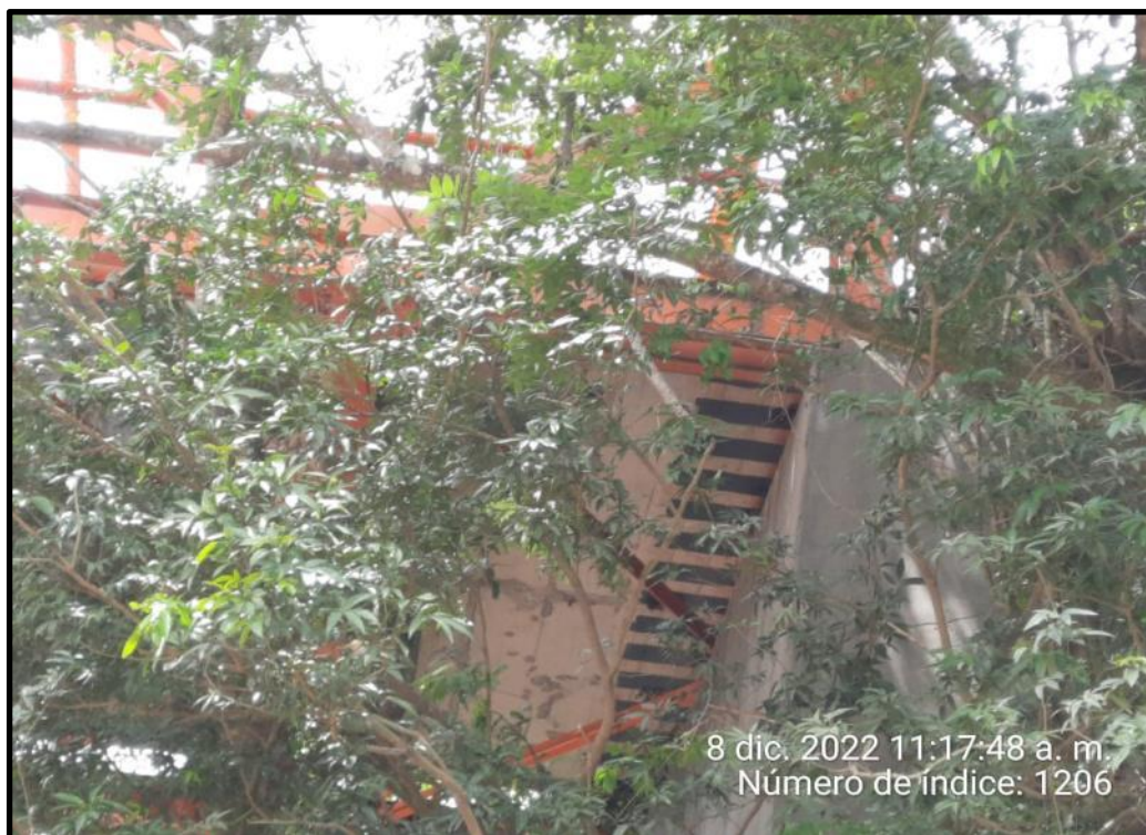
Foto N°34: Se aprecia el muro contrafuerte final Picota - Tarapoto
