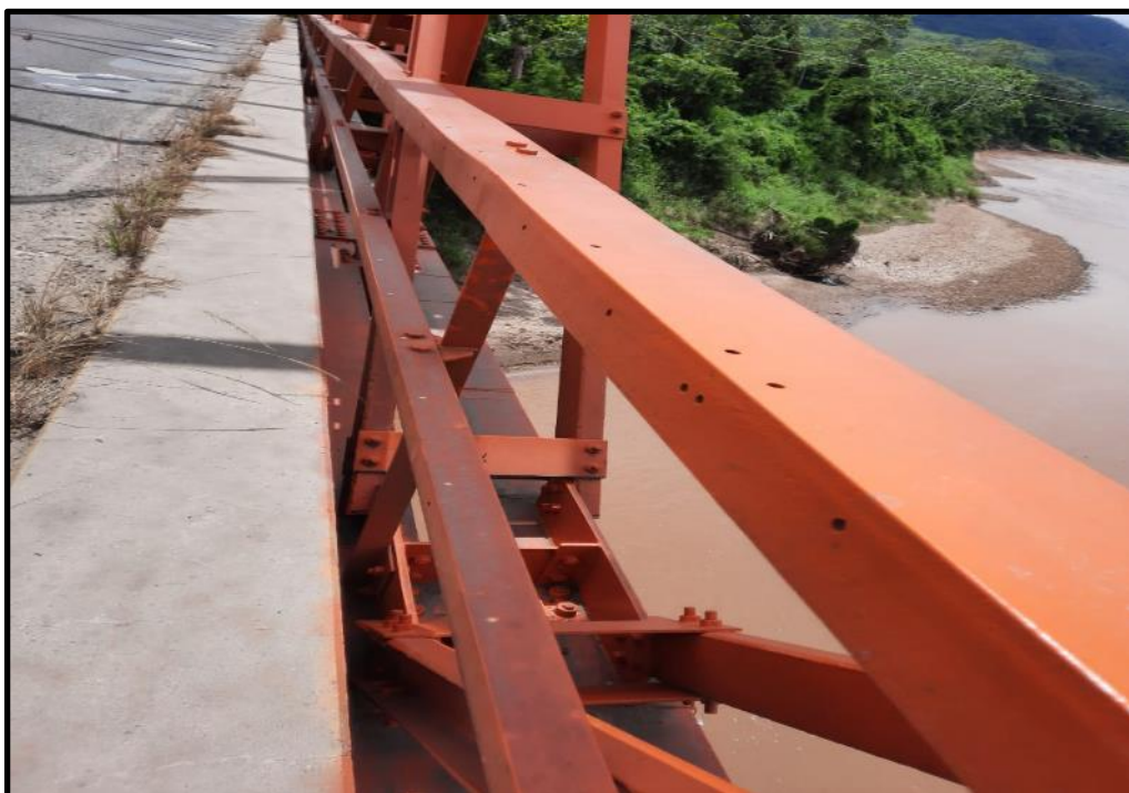
Foto N°19: Se aprecia el estado actual de la sección metálica - Lado derecho
