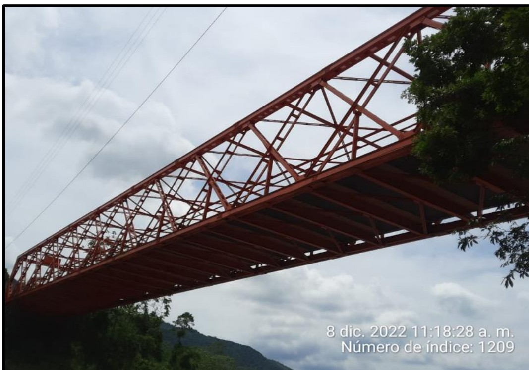
Foto N°32: Se aprecia las vigas longitudinales y transversales metálicas
