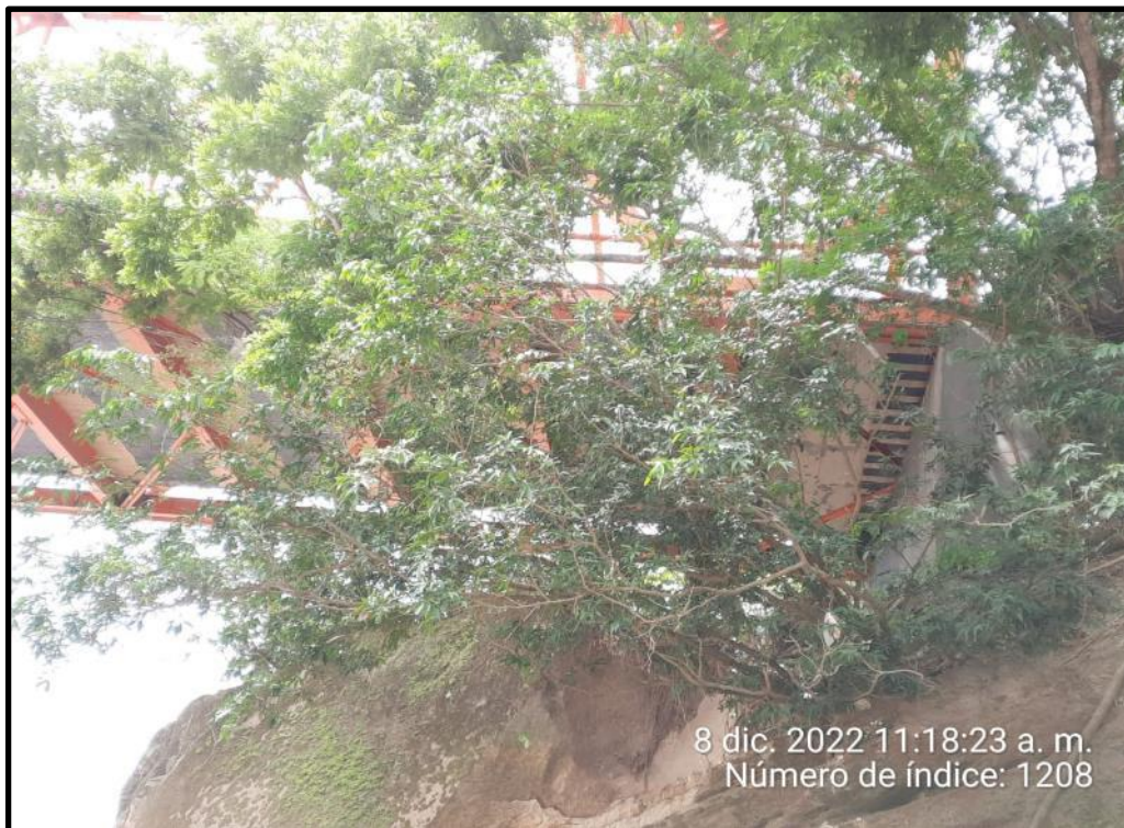
Foto N°33: Se aprecia el muro contrafuerte ingreso Tarapoto-picota.
