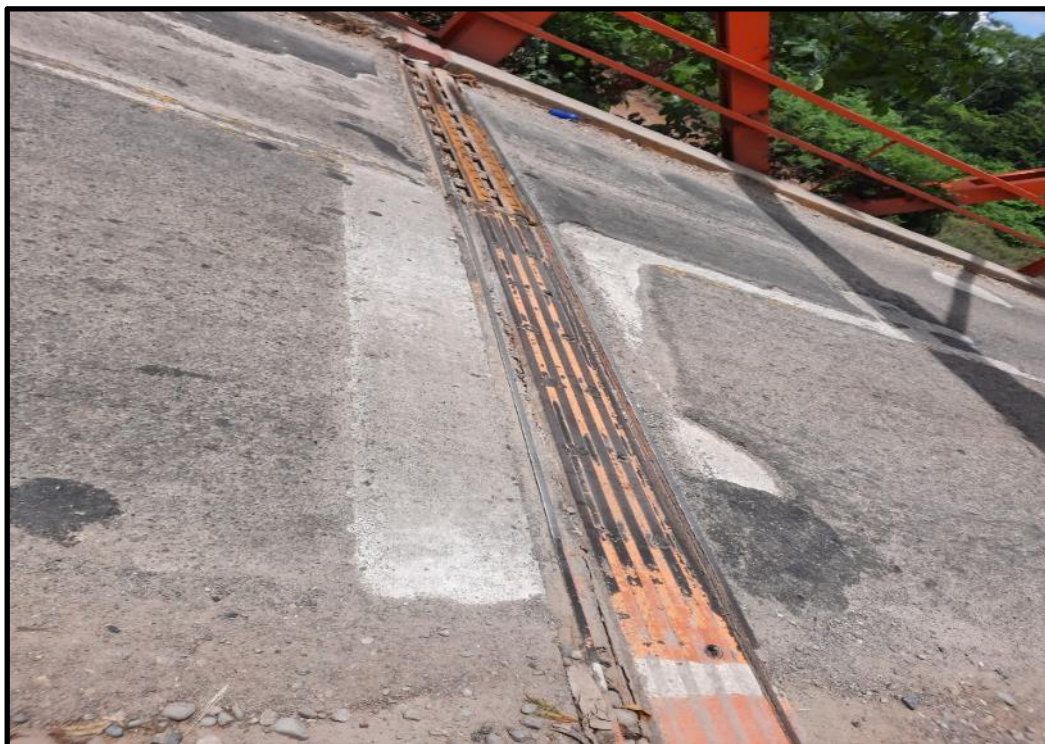
Foto N°26: Se aprecia l plancha deslizante Junta de dilatación parte final del puente.
