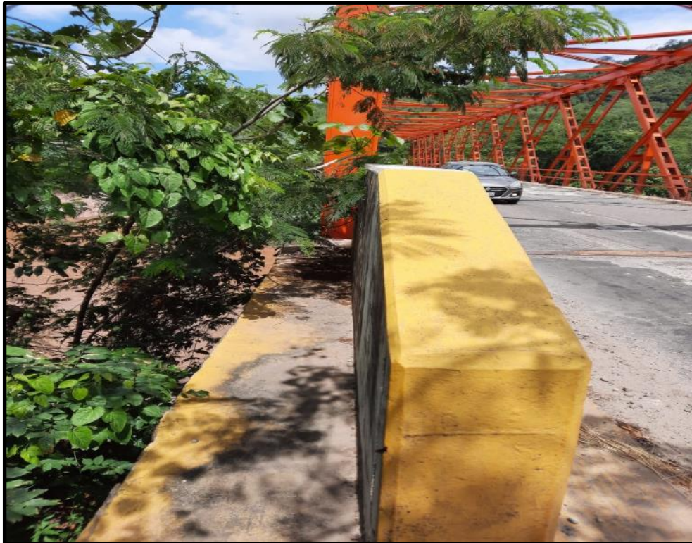
Foto N°27: Se aprecia el guardavia de concreto Lado izquierdo.
