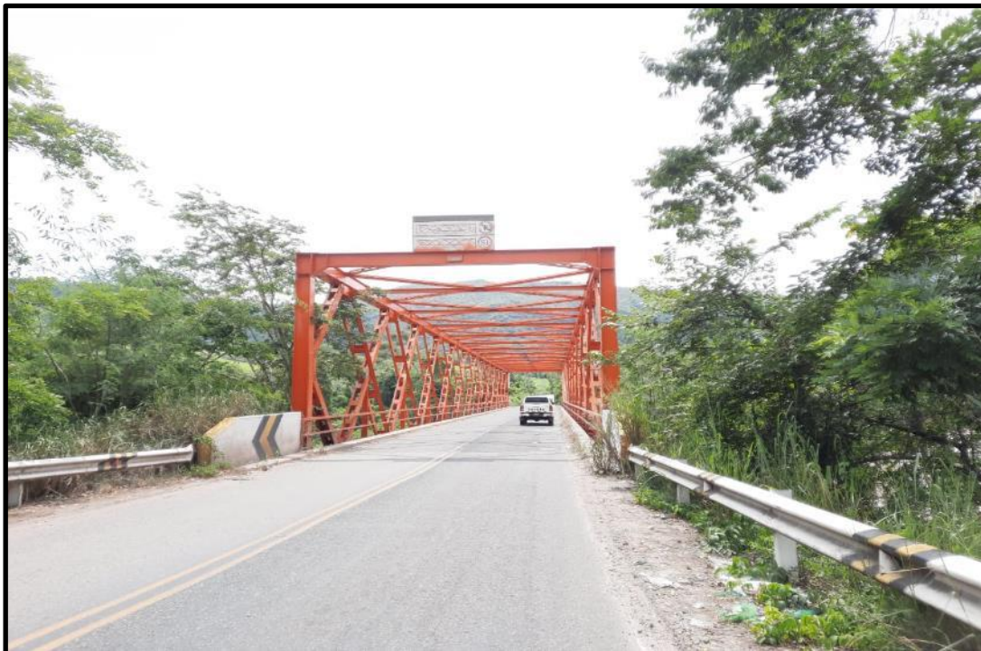
Foto N°01: Vista Principal del Puente Colombia del tipo Atirantado.
