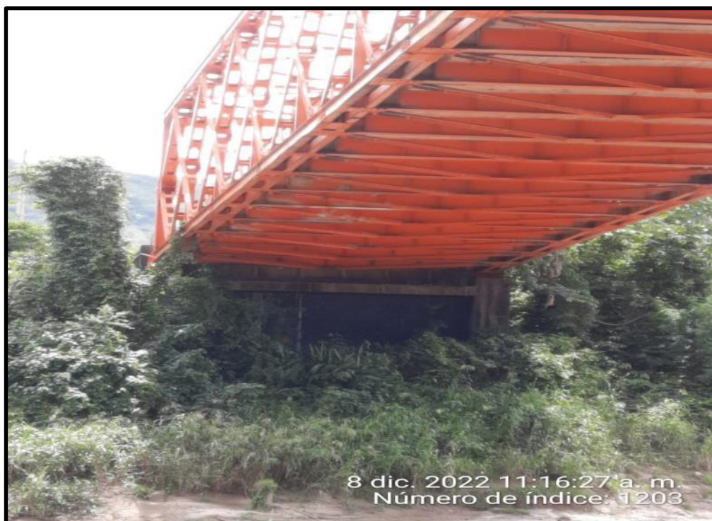
Foto N°36: Se aprecia los pilares del puente salida a picota.
