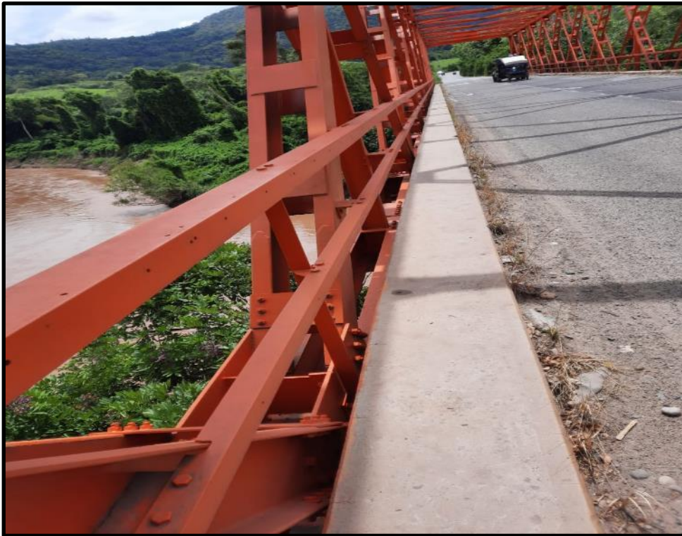
Foto N°08: Se aprecia el estado de las secciones metálicas y vereda
