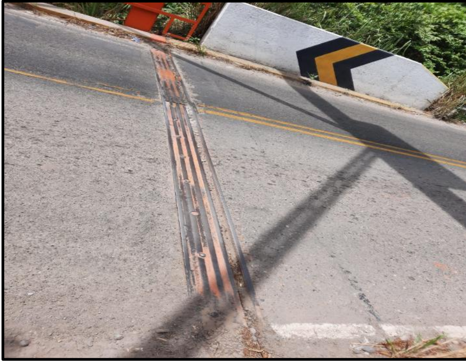
Foto N°05: Se aprecia el estado actual de la junta de dilatación.
