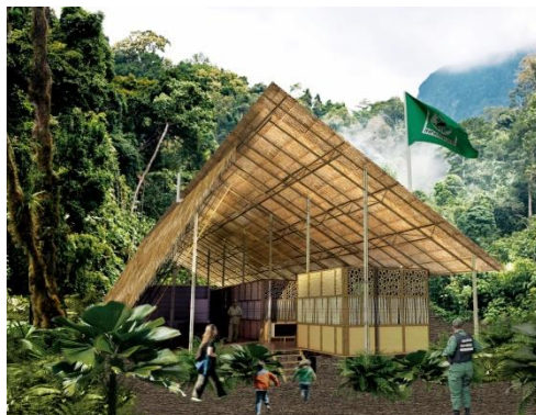
vivienda con estructura de madera redonda y recubierto con lona y hoja de palmera para mitigar la radiación solar.
