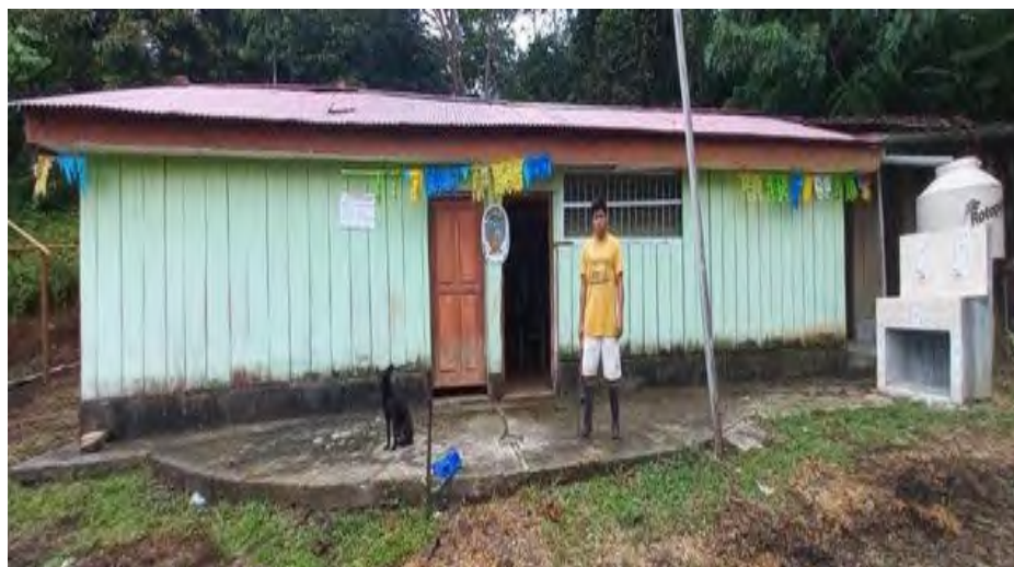
Imagen 2. Colegio Rural Unidocente construida con tabiquería de madera y cobertura de calamina corrugada de zinc.
