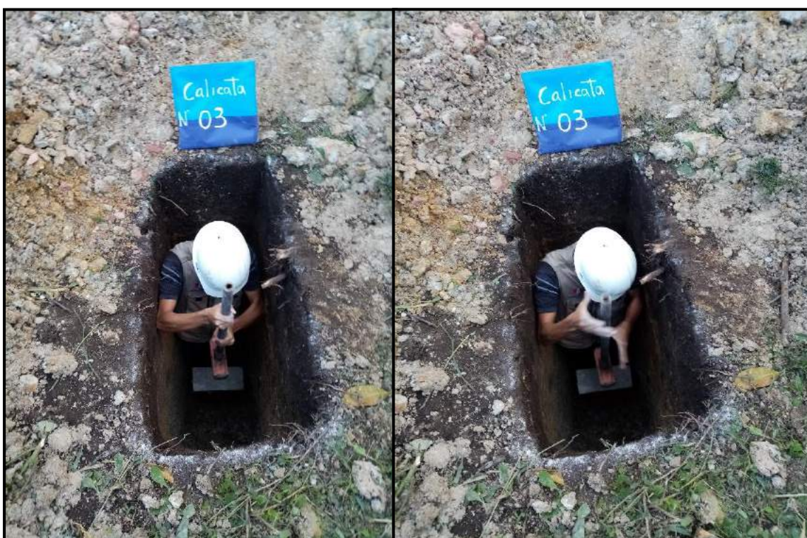
Foto 54: Se ejerce presión en el molde dejando caer la comba por efecto de gravedad para toma de muestra en C-03
