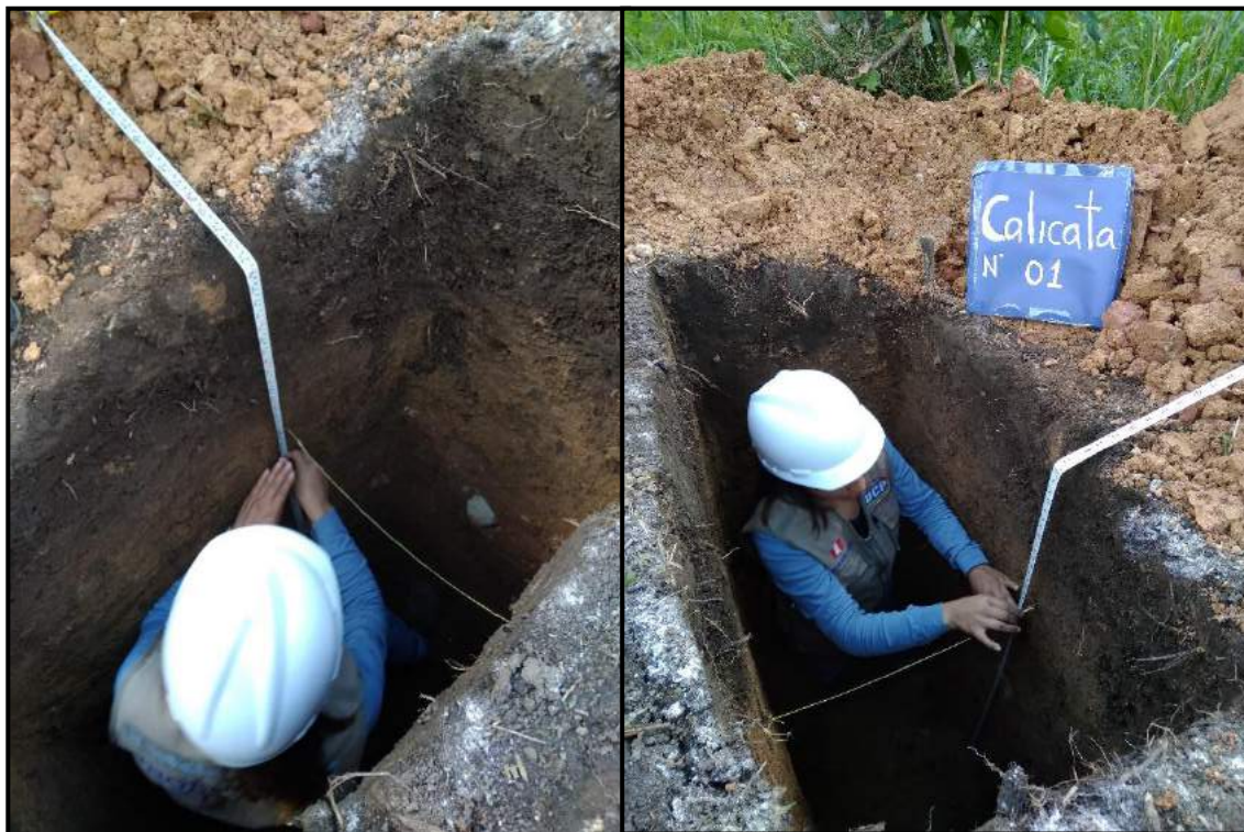
Foto 23: Medición de 1 m de altura desde el fondo de calicata y colocación del hilo con clavos para calicata C-01
