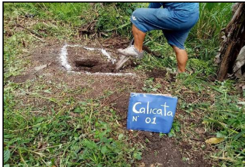
Foto 2: Excavación de calicatas
