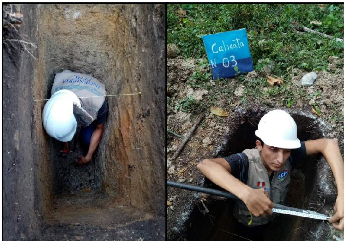
Foto 31: Medición de la profundidad de perforación de la barra en el suelo en C-03
