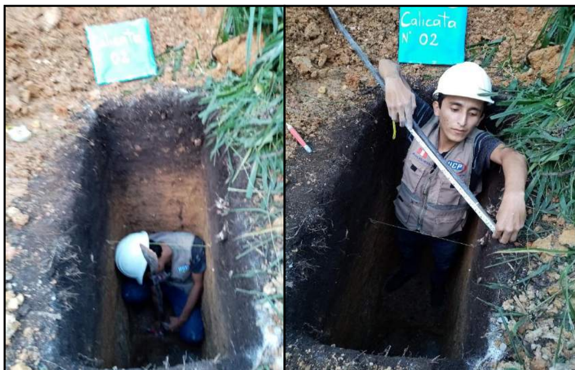
Foto 28: Medición de la profundidad de perforación de la barra en el suelo en C-02
