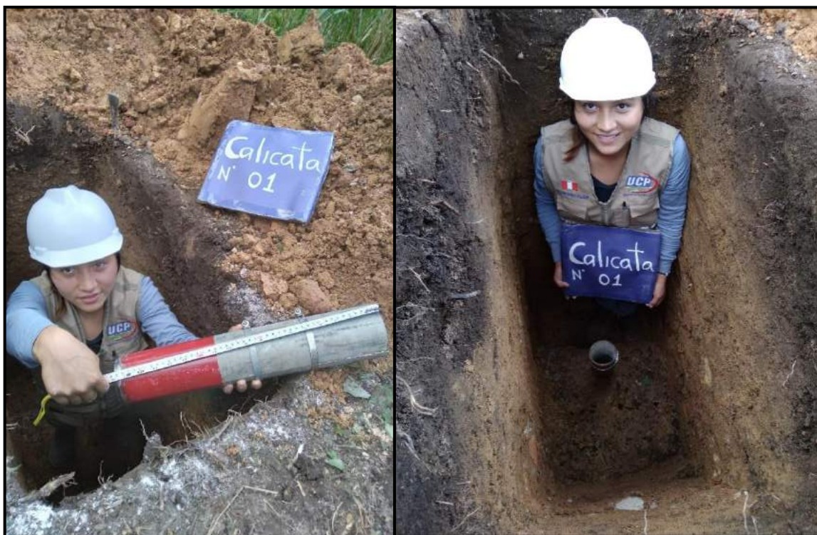
Foto 32: Colocación de molde metálico cilíndrico para extraer la muestra del corte directo en C-01
