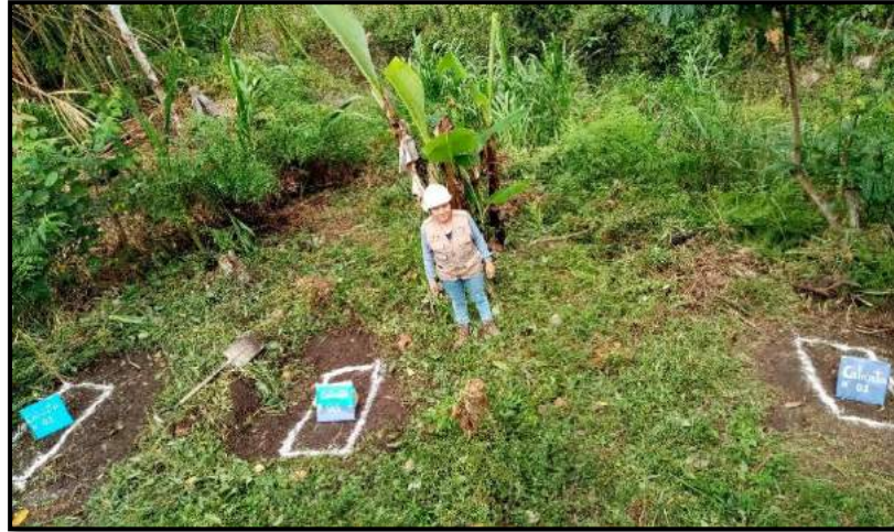
Foto 1: Trazo de calicatas
