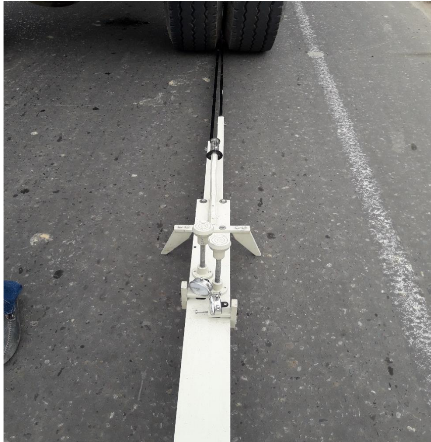
Figura N°05: Viga Benkelman en campo durante el ensayo
