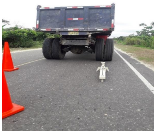
Figura N° 09: Colocación de la viga
