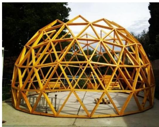
Imagen N°36 Domo Geodésico Fuente: Elaboración Propia
