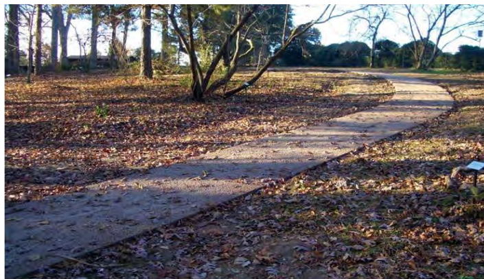
Figura 4: Acumulación de finos y material vegetal
