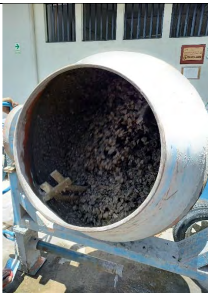
Foto 19: MEZCLA DE CONCRETO PERMEABLE EN EL TROMPO
