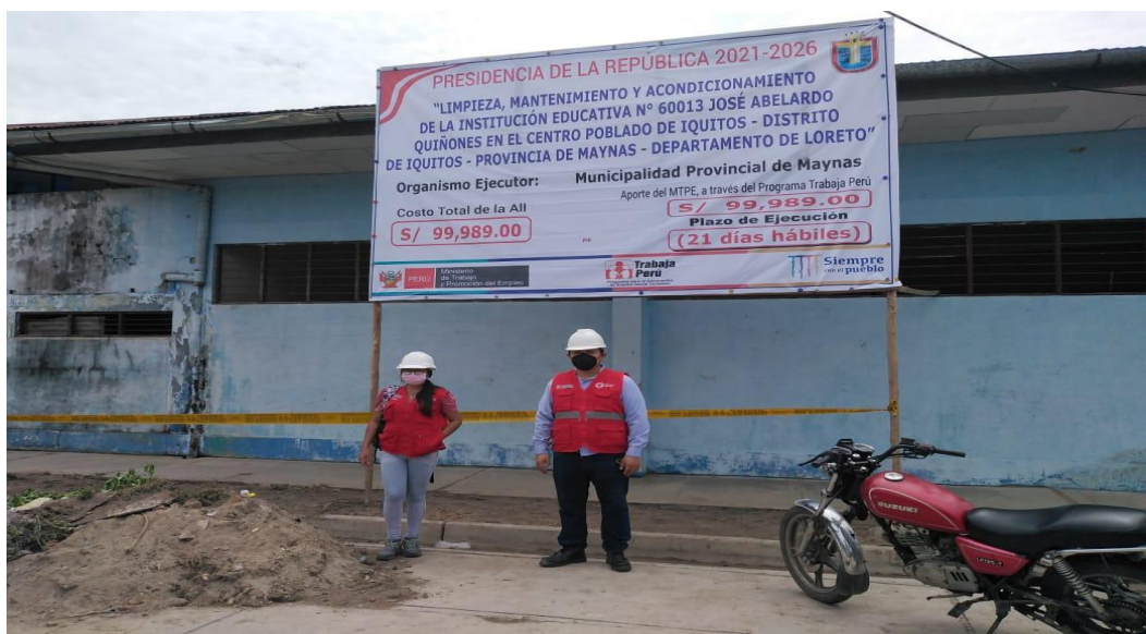
FOTOGRAFÍA 03: CERCO DE SEÑALIZACIÓN
