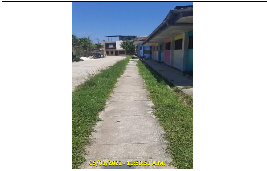
SE OBSERVA LA CALLE DONDE SE UBICA LA IE CON MALEZA.
