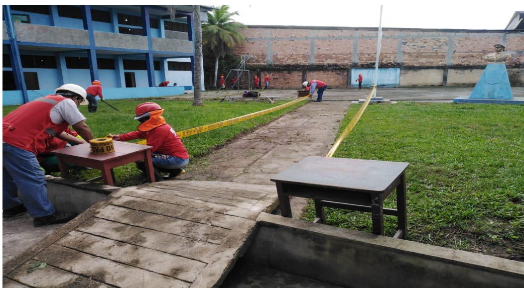
FOTOGRAFÍA 04: INSTALACIÓN DE SEÑALIZACIÓN
