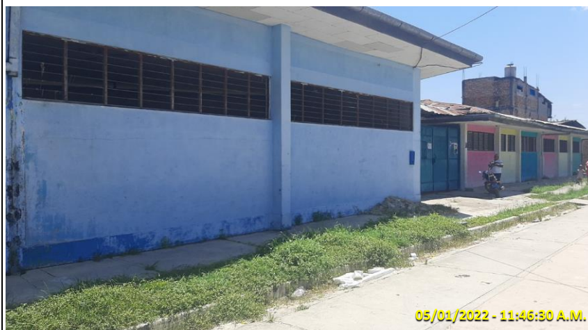
TRAMO DE LA FACHADA. SE OBSERVA MALEZA EN LAS AREAS VERDES Y MATREIAL DE DESMONTE.
