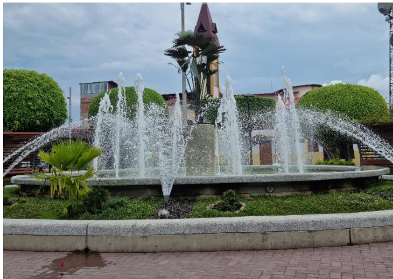
Garfico 32:parque central en mal estado
