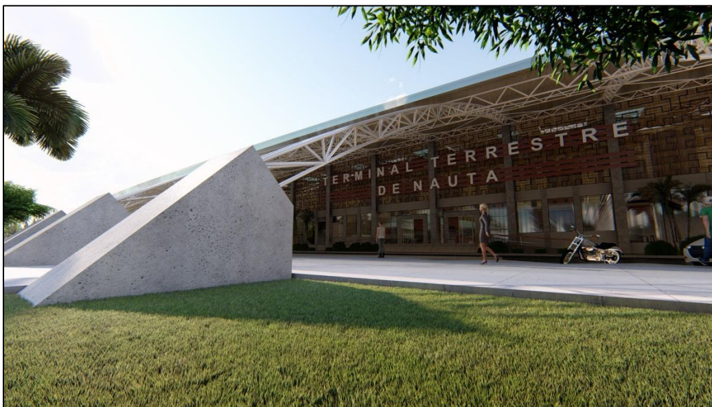
IMAGEN 39. Vista de las bases en donde sale la cobertura techada.
