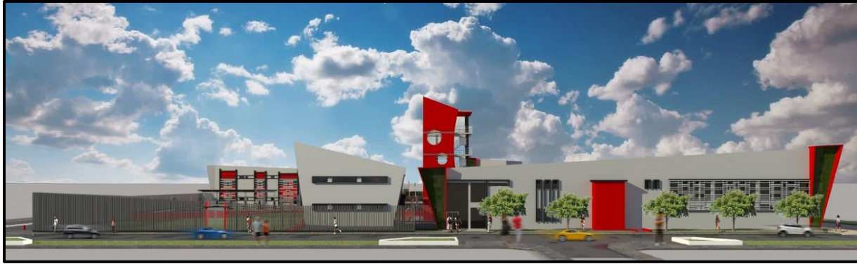
Figura 83. Pendiente de Cobertura – Jirón Libertad.
