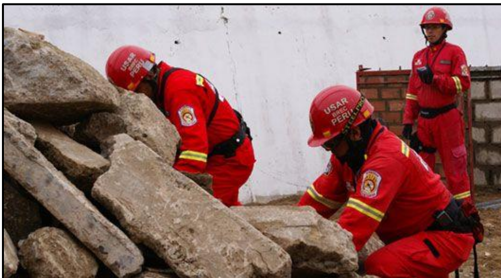
Figura 114. PRÁCTICA. Rescate en Estructuras Colapsadas.
