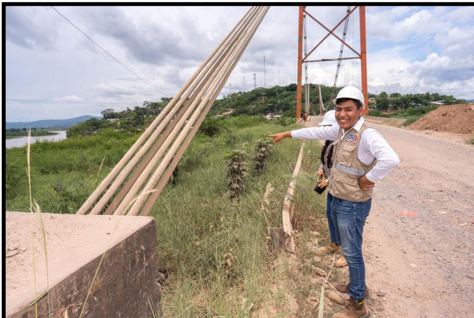
Foto 2: Vista de los cables principales de acero del Puente Picota.
