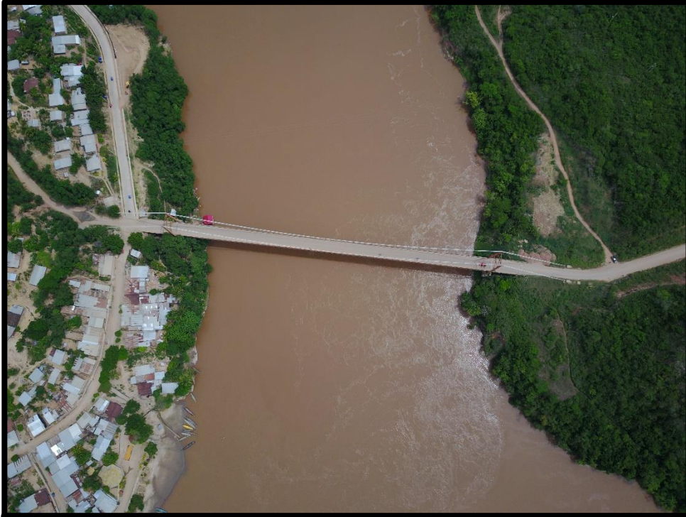
Foto 5: Vista aérea en planta del puente Picota.
