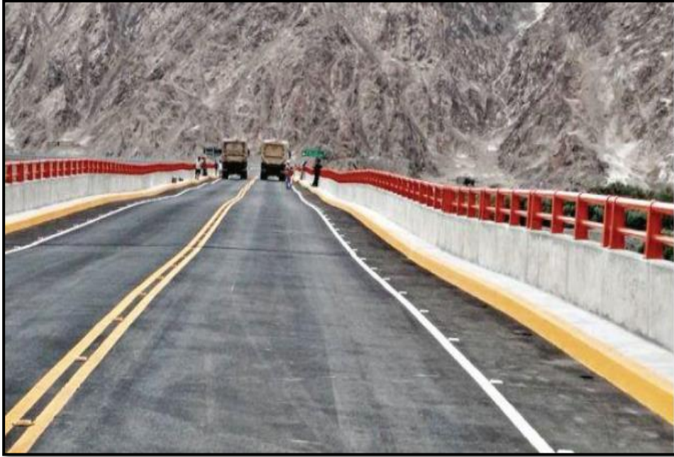
Ilustración 13: Deformación de la Plataforma del Puente sobre el Rio Quilca
