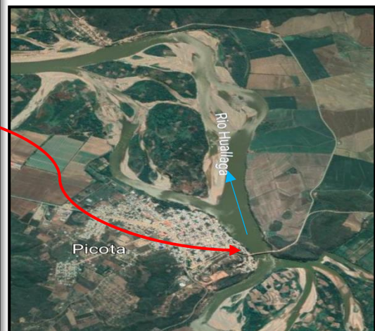
Ilustración 20: Ubicación Puente Picota
