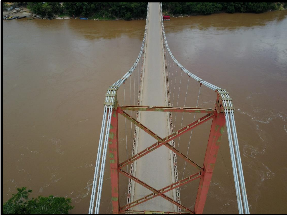
Foto 9: Vista aérea de los cables principales y péndolas del puente Picota.
