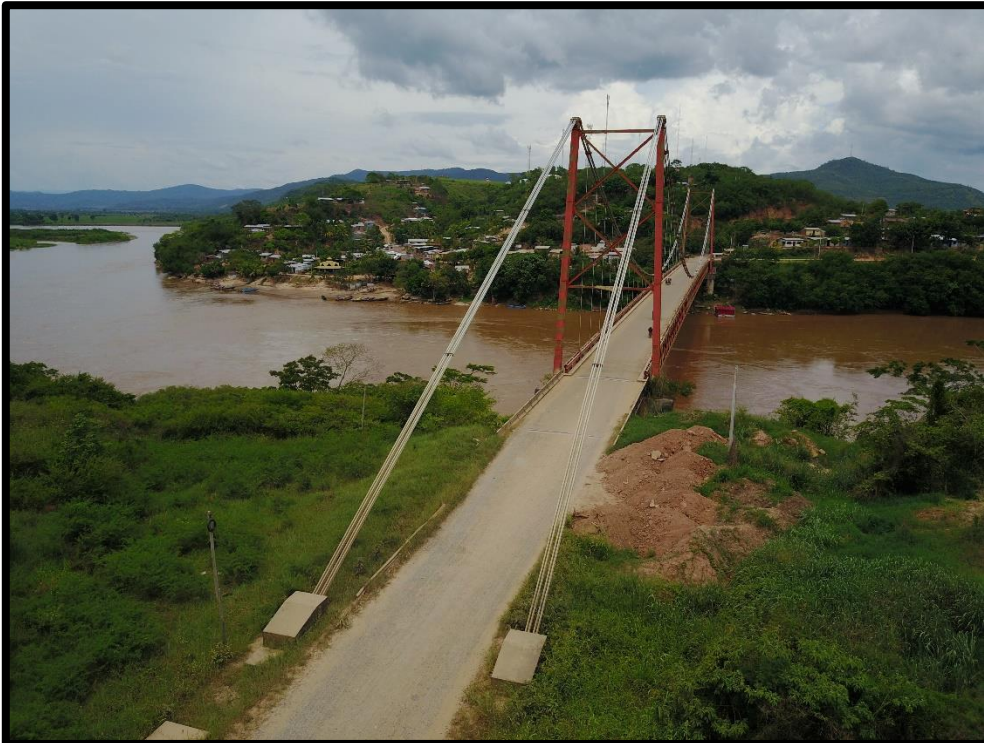
Foto 7: Vista aérea de los cables principales del puente Picota.
