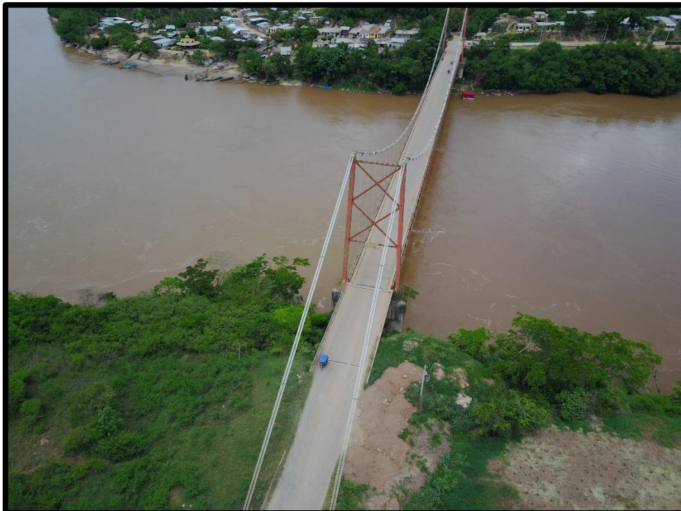
Foto 8: Vista aérea de los cables principales del puente Picota.
