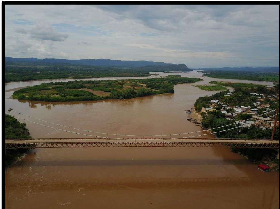
Foto 4: Vista del puente Picota aguas arriba.
