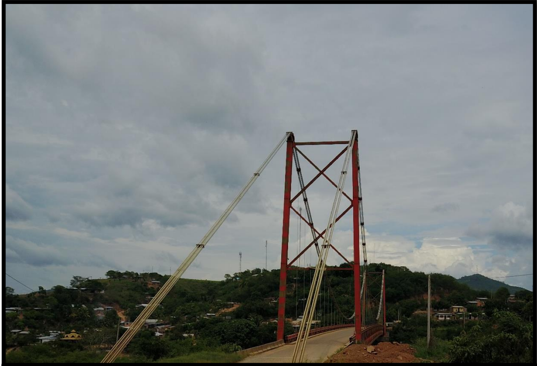
Foto 3: Vista Frontal de la torre de la margen izquierda del Puente Picota.
