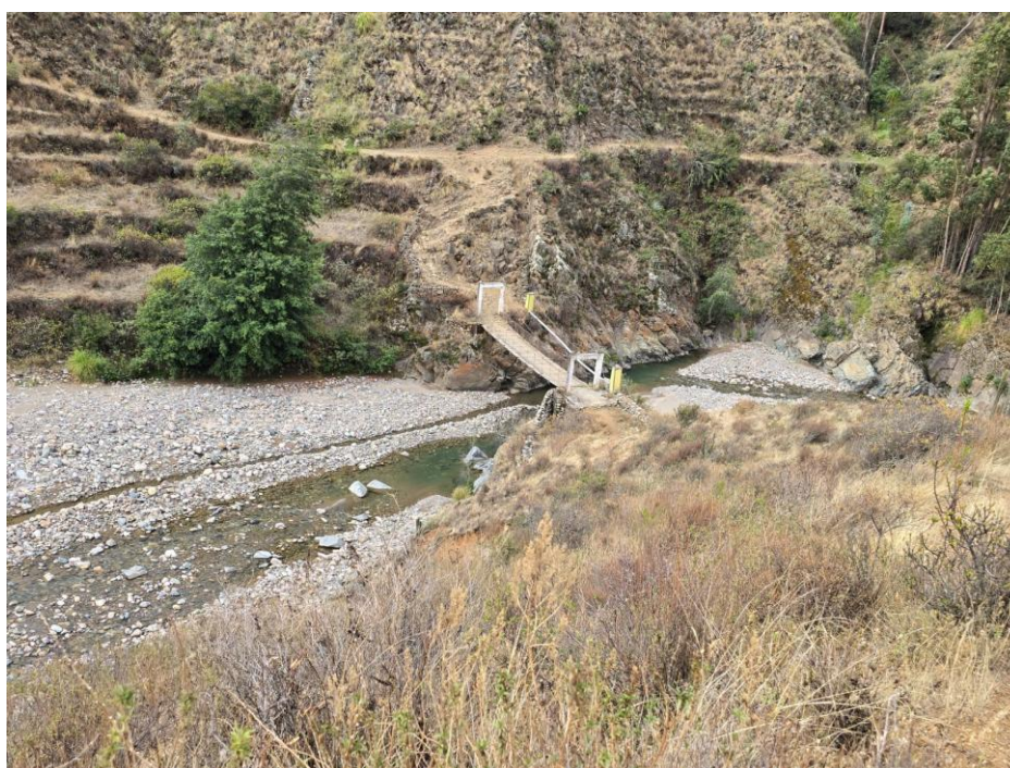
Vista general actual del puente Tincocc
