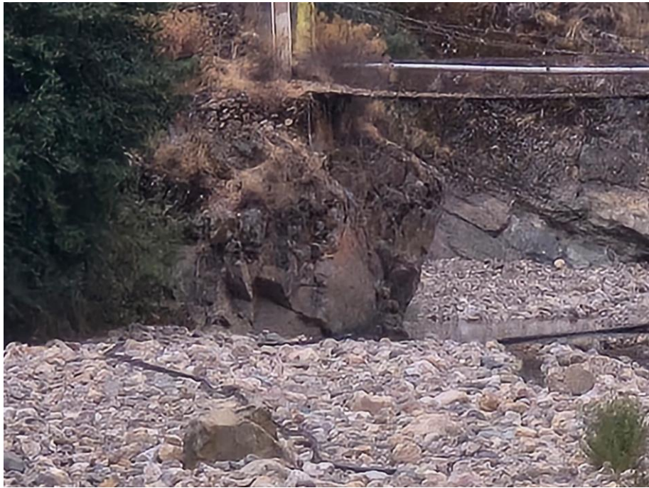
Estribo izquierdo del puente Tincocc
