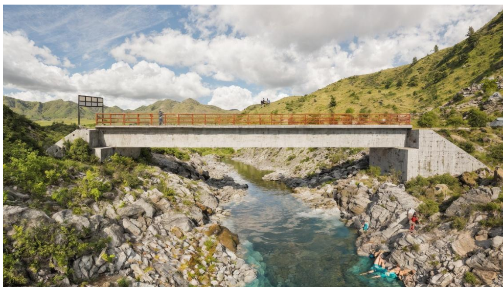
Vista lateral aguas arriba
