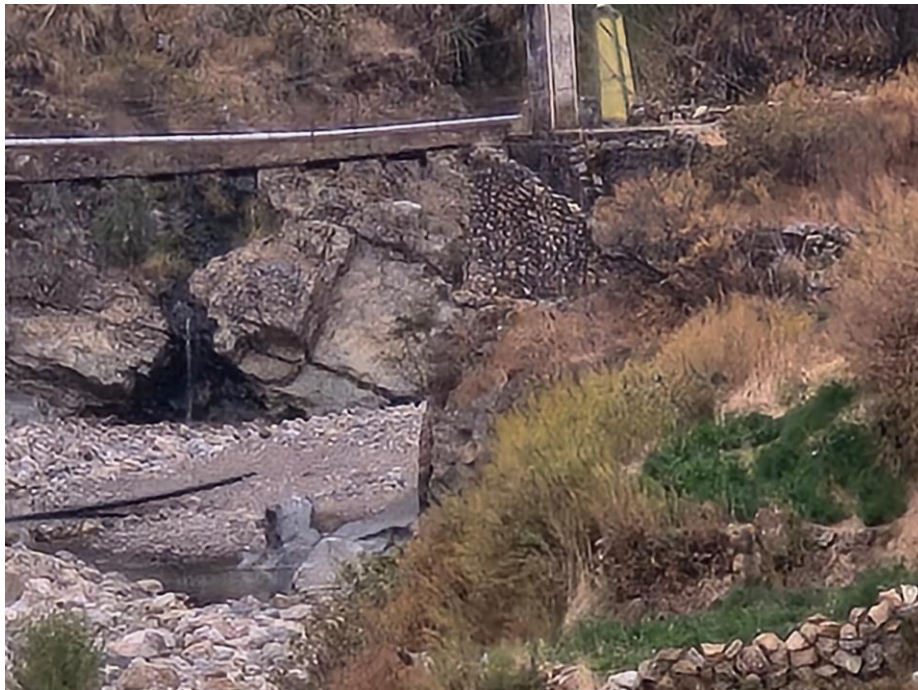
Estribo derecho del puente Tincocc
