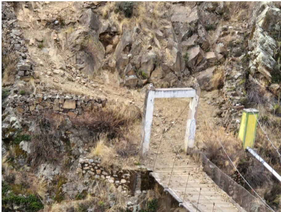
Vista de ingreso al puente Tincocc
