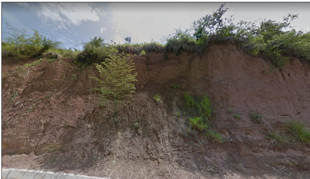
Figura 33: Vista frontal del talud estudiado.
