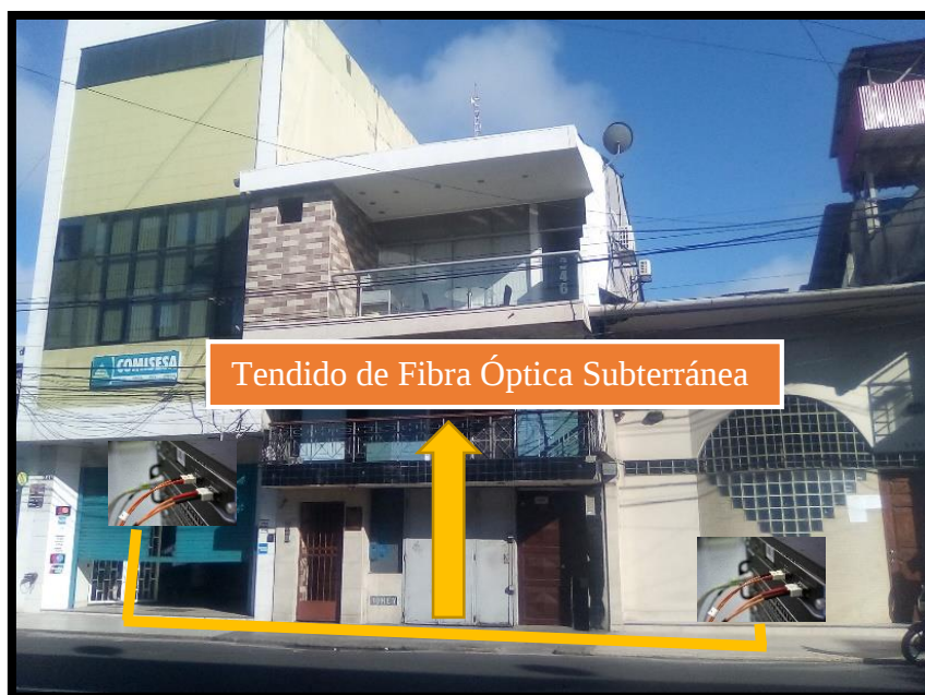
Figura N° 13: Conexión entre de ambos locales de la empresa por fibra Óptica
