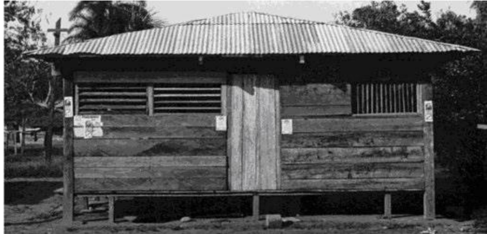
Figura 55. Foto 4 - Vivienda moderna con techo de 4 aguas.
