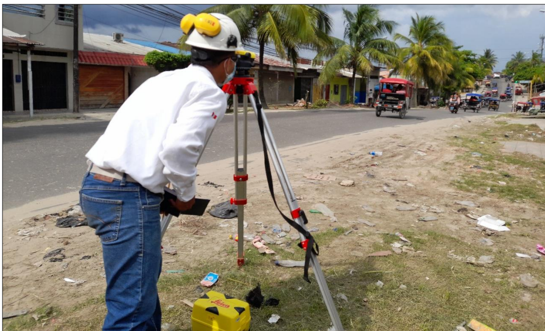
Fotografía 8 Determinando la pendiente de la Av. Participación en el tramo comprendido entre la Urb. Rio Mar con Jr. Calle 6 de Rio Mar de la ciudad de Iquitos con ayuda del Nivel de Ingeniero
