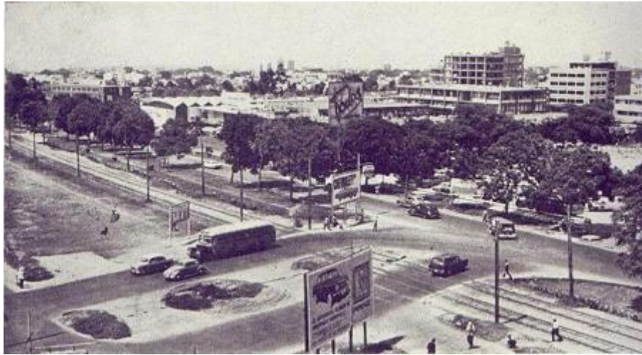
GRAFICO N° 03: Centro comercial "todos" (San isidro), antes de que se construyera el "zanjón"
