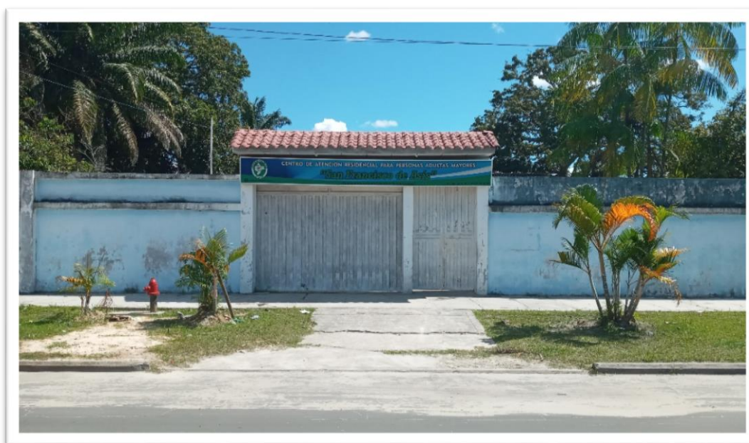
Figura 2: Fachada del Asilo de Ancianos “San Francisco de Asís” Fuente: Autoría Propia
