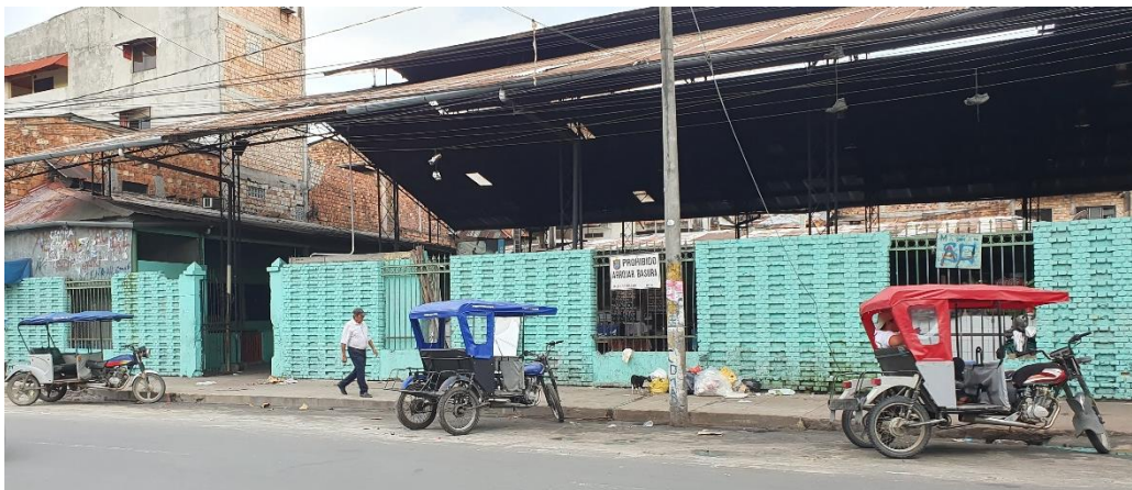
Figura 46. Deterioro del muro perimétrico del mercado por la ca. Moore. Fuente: Propia.
