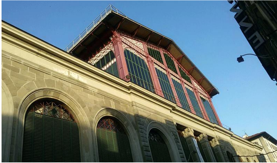
Figura 18. Ventanales arcados del Mercado Central de Florencia. Tomado de: www.e-struc.com
