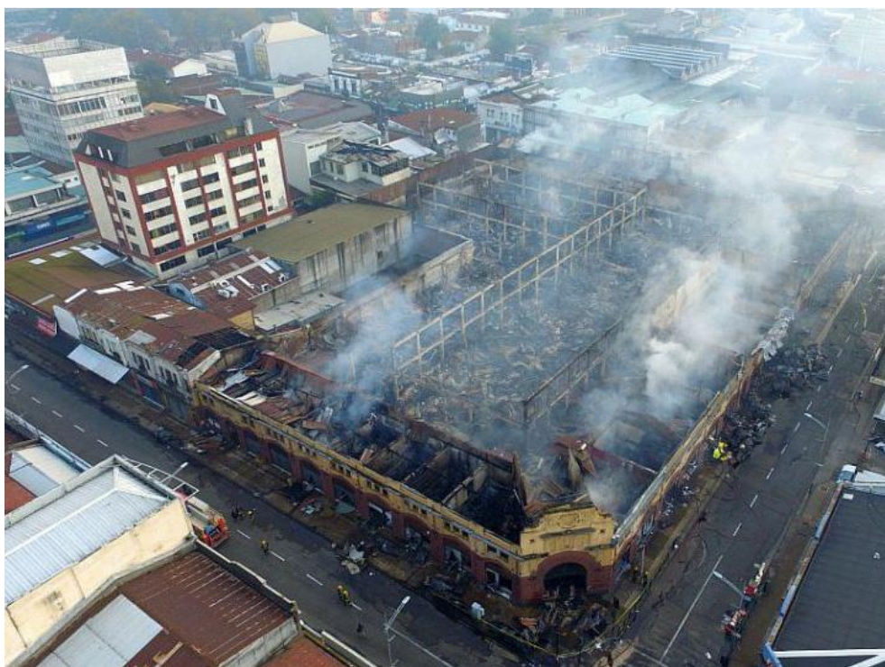
Figura 10. Escombros del mercado central de Temuco posterior al incendio. Fuente: Bravo, 2018.
