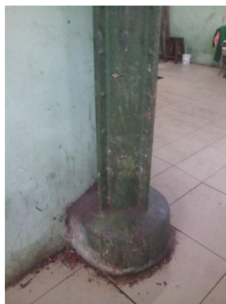
Figura 38. Pilar metálico y base de concreto. Fuente: Elaboración propia.
