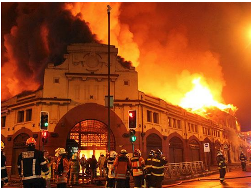
Figura 09. Incendio en el mercado central de Temuco. Fuente: Bravo, 2018.
