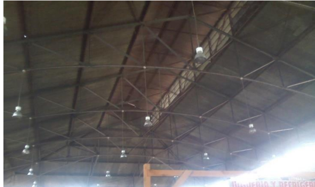
Figura 40. Vigas metálicas del Mercado Central de Iquitos. Fuente: Elaboración propia.
