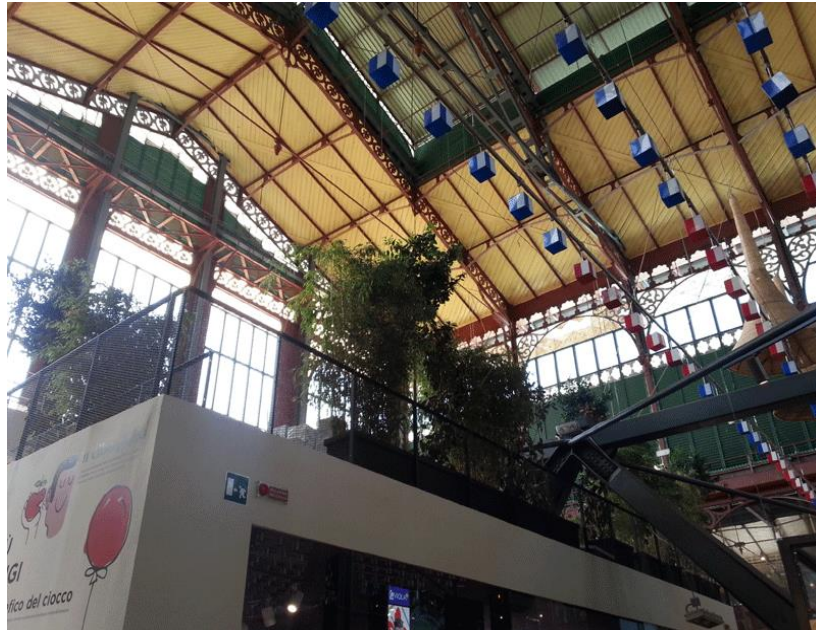
Figura 20. Estructura metálica del Mercado Central de Florencia. (2017, Octubre 16) Tomado de: www.e-struc.com
