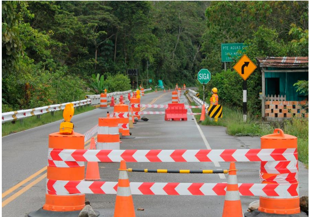
FIGURA 02: (Uso de Elementos de Protección Colectiva)
