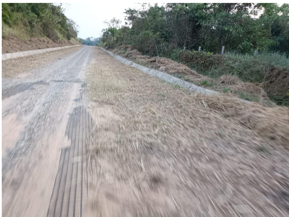
Vista de cunetas a ambos lados.
