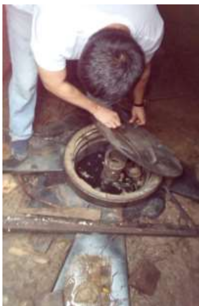
Figura N° 9. Muestra de Tanque
