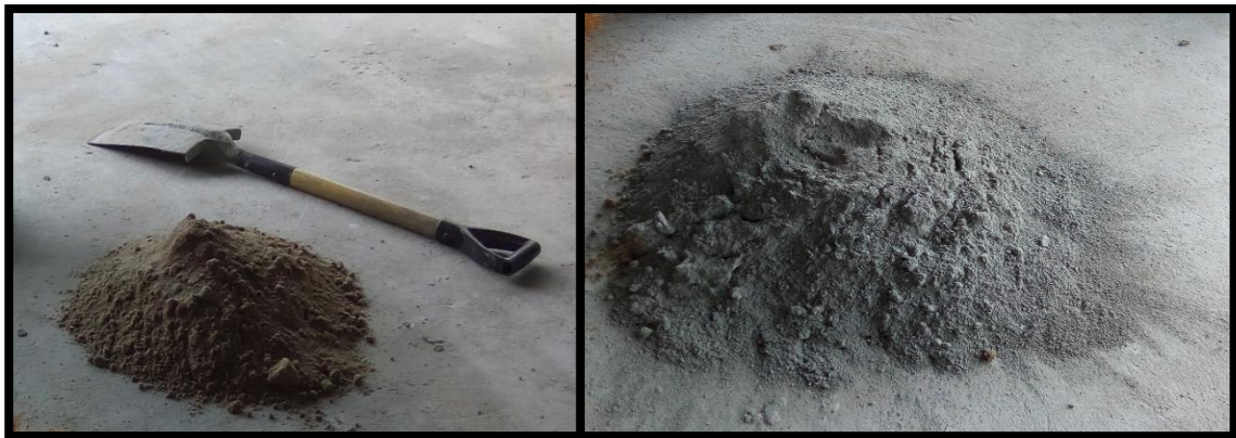
Mezcla de la arena con el cemento
