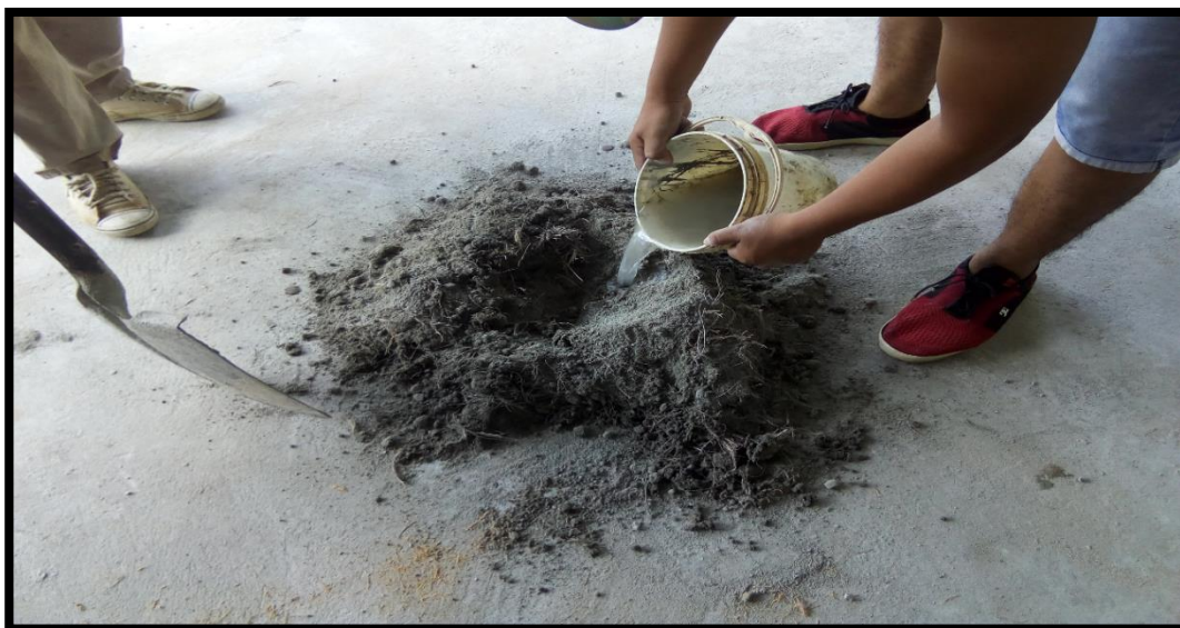
Figuras N° 25. Procedimiento de fabricación del ecobloque
