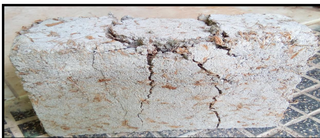
Falla del ecobloque
