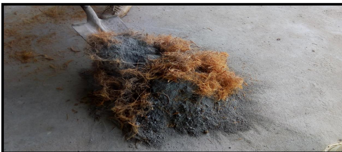
Mezcla de la fibra de coco juntamente con la arena y el cemento
