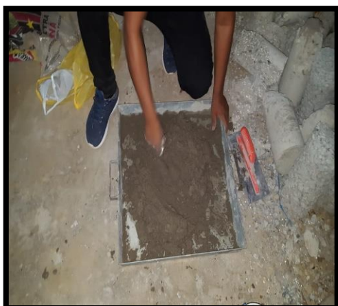
Realización del mortero
