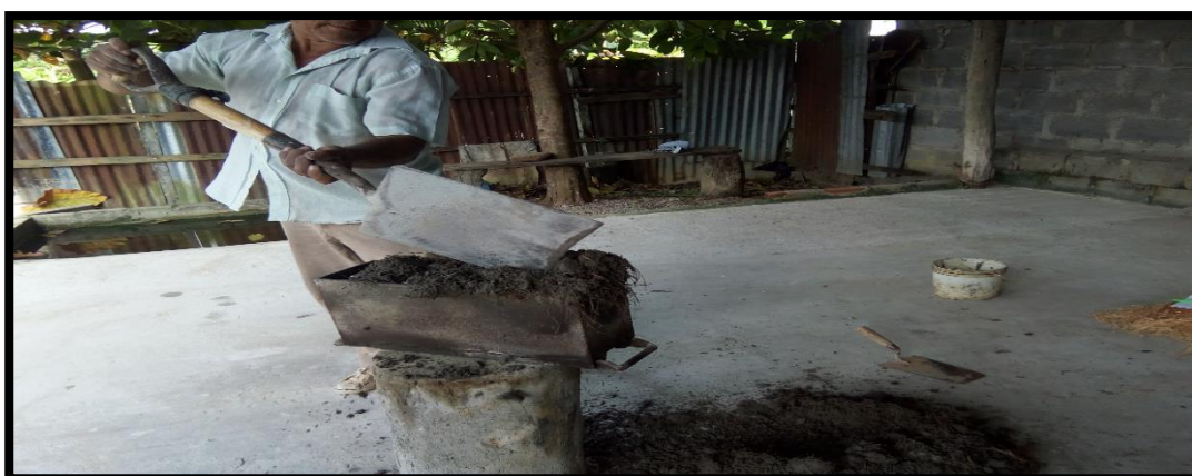
La mezcla compacta, con una palana lo colocamos en el molde del bloque
