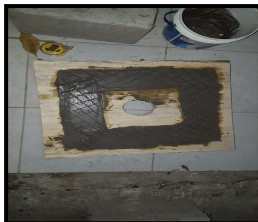
Adherir el mortero en la base de madera
