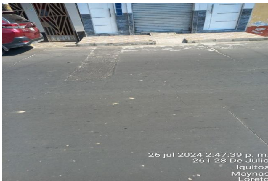
PARCHEO (Progresiva 0+270.00 - 0+300.00 lado derecho)
