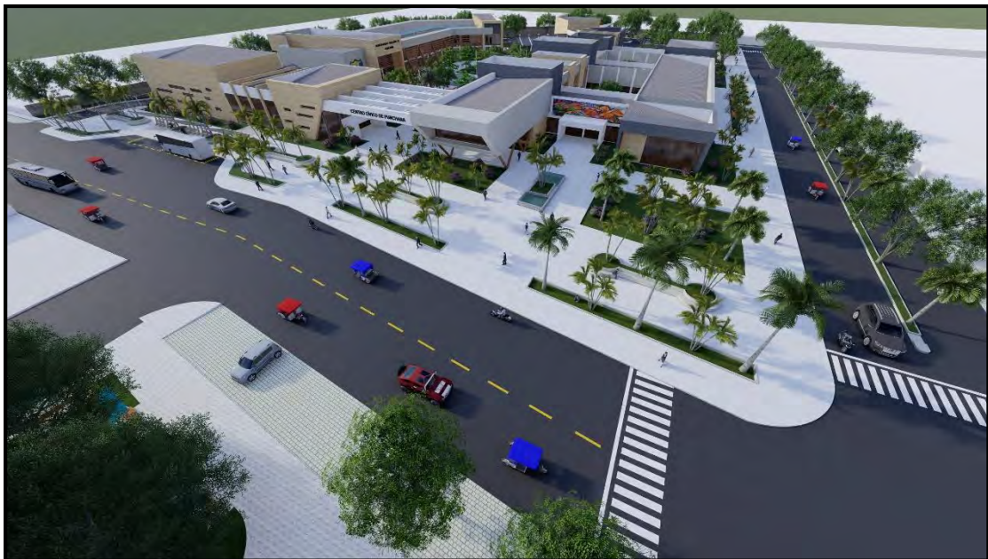
VISTA AV. 28 DE JULIO – LADO DERECHO.
