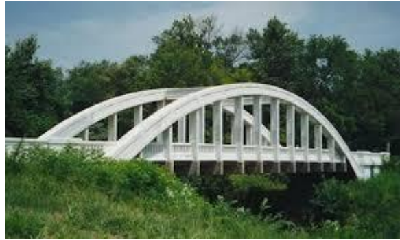
Imagen 7: Puente en arco.
