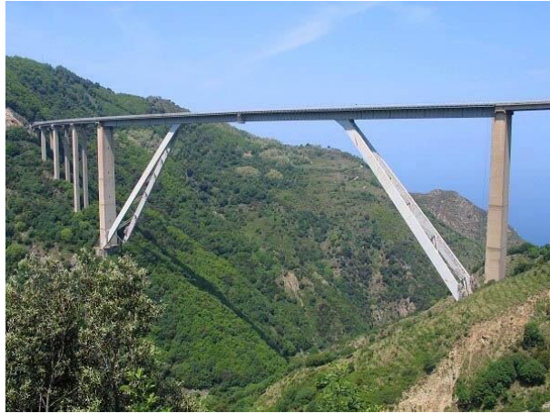
Imagen 9: Puente pórtico Sfalassà (Italia, 1974) (Fuente: Wikipedia).
