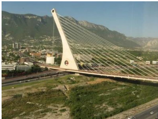
Imagen 8: Puente atirantado - puente que cruza el río Santa Catarina conectando a Monterrey con San Pedro Garza García (Fuente: Wikipedia).
