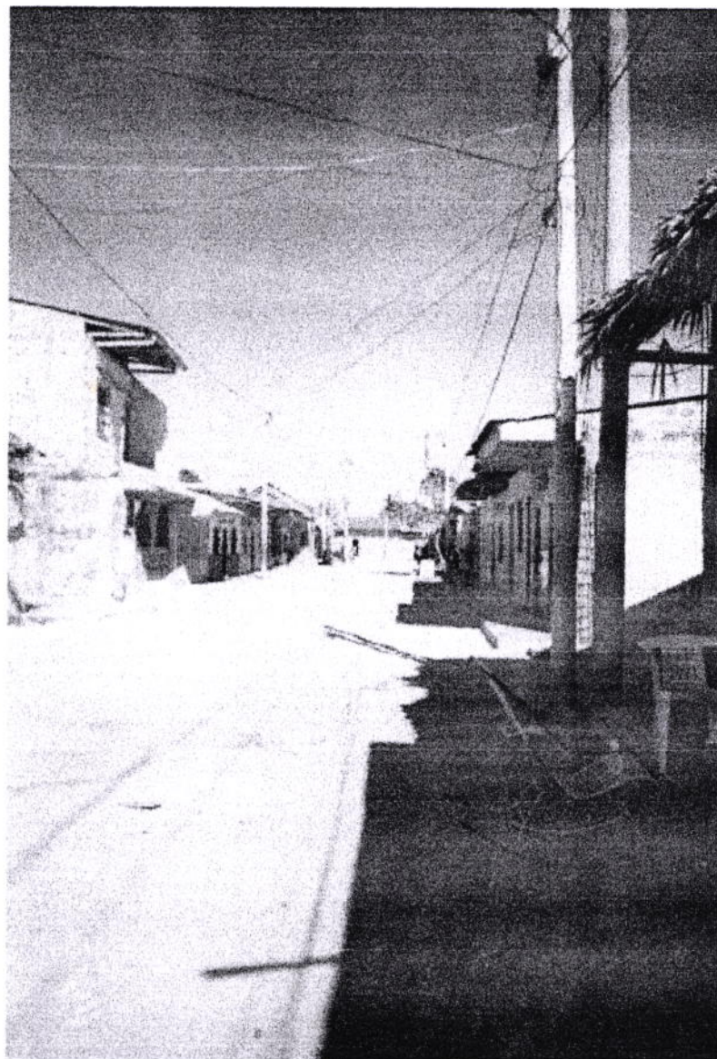
CALLE 2 DE FEBRERO AL MOMENTO DEL LEVANTAMIENTO TOPOGRAFICO
